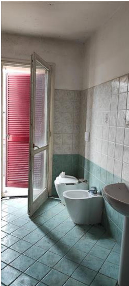
bagno al primo piano
