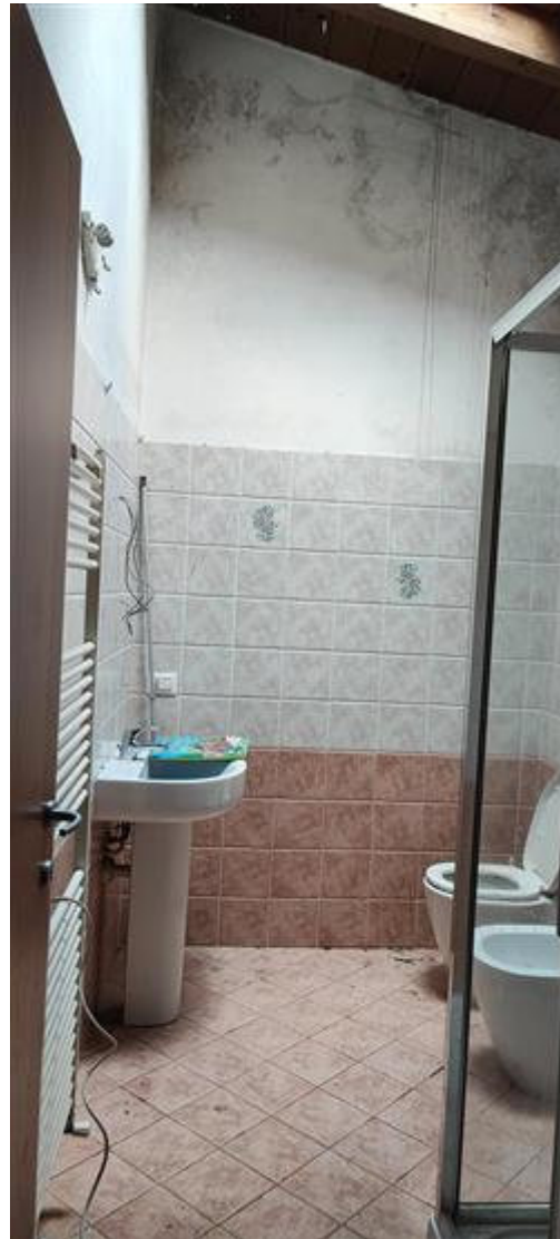
bagno al secondo piano
