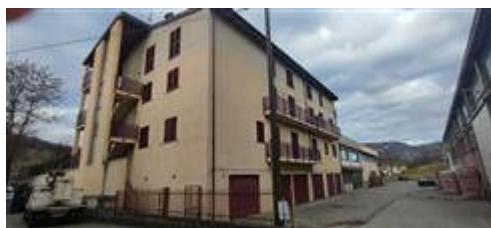
vista esterna lato nord est
