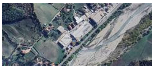
particolare vista aerea dell'immobile in zona mista artigianale
