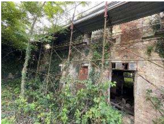
foto 3 prospetto Nord -abitazione-
