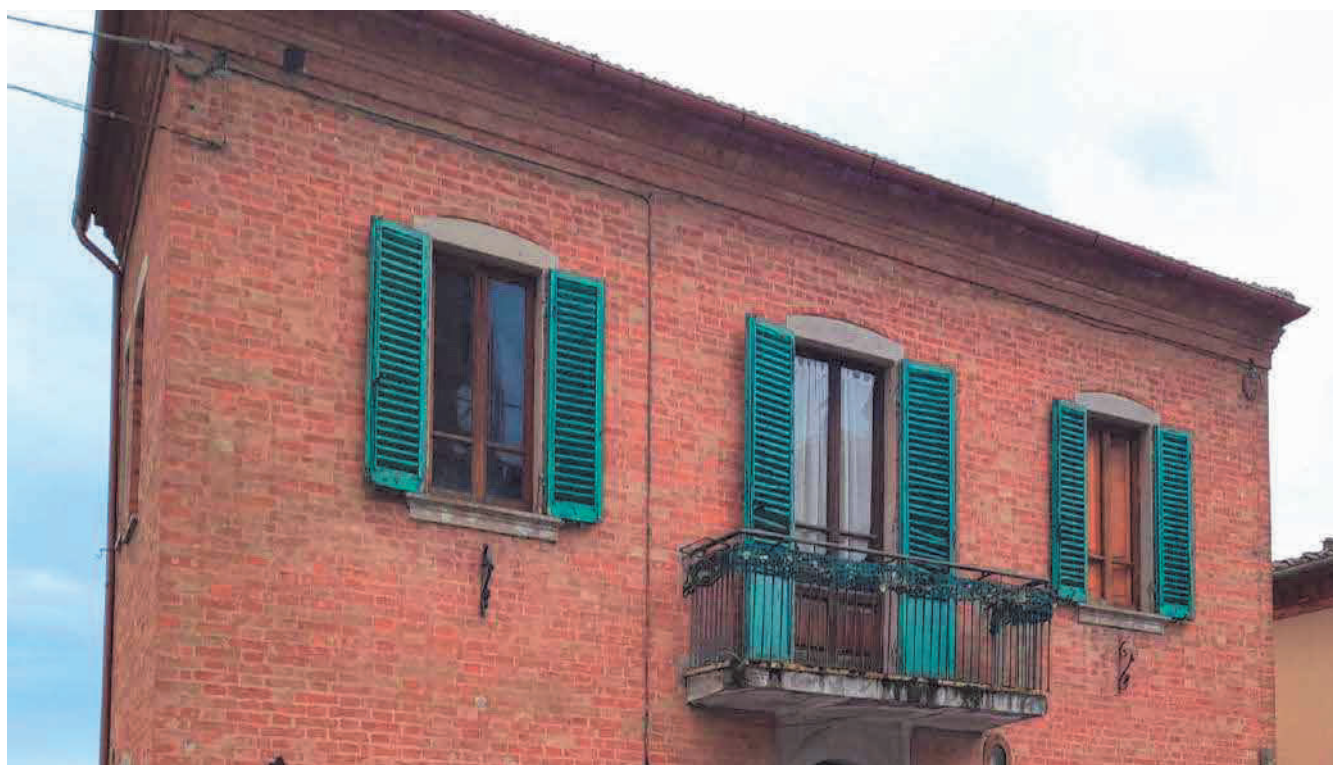
Particolare infissi e terrazzino
