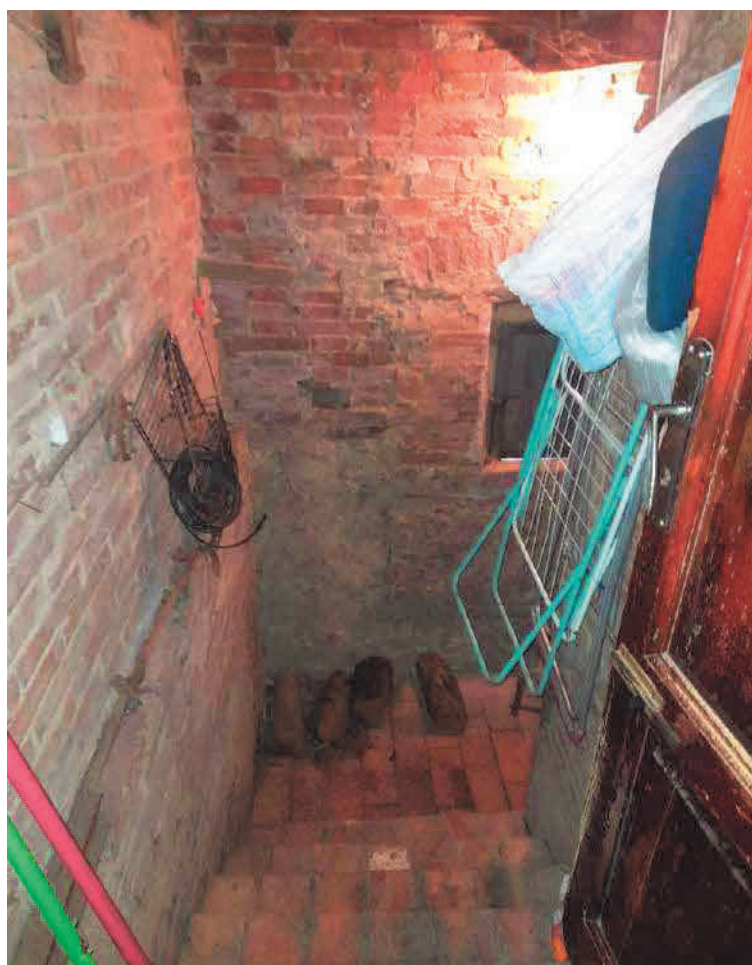
Scala di accesso al p.S1
