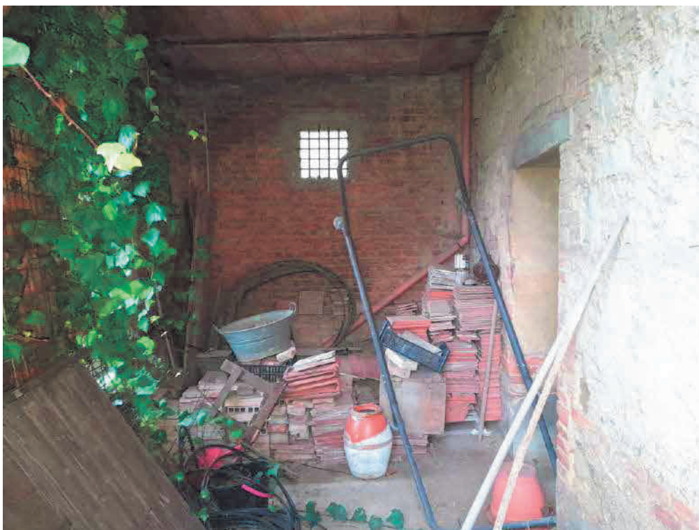
Interno tettoia p.S1
