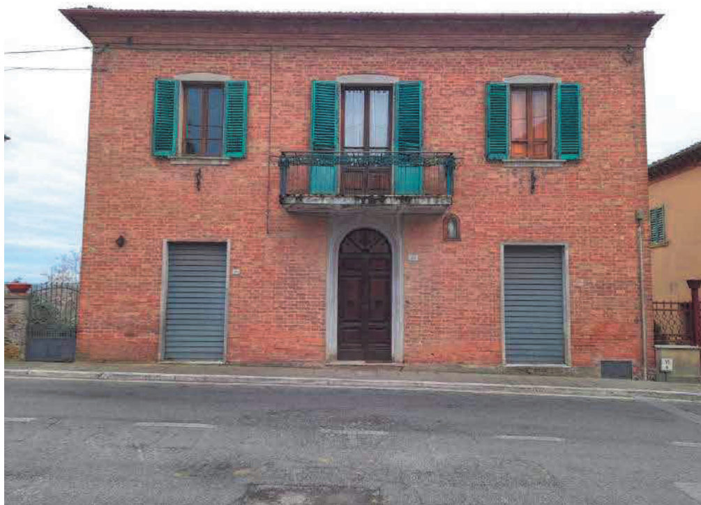
Prospetto principale di Via Lauretana nord
