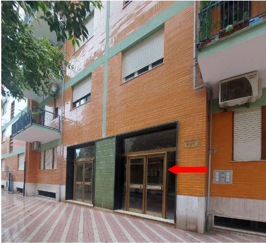
Fabbricato est – accesso scala A
