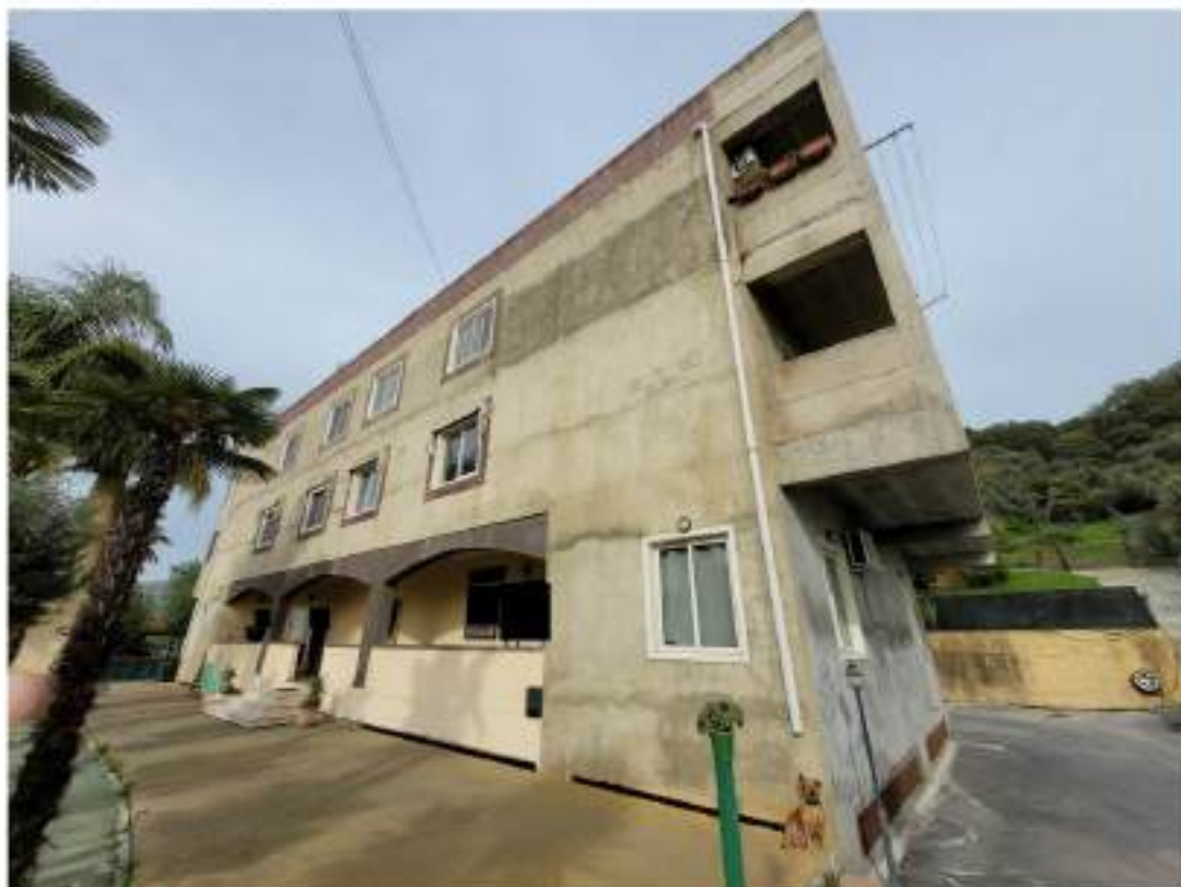
Foto n. 4. Fabbricato e area di pertinenza esterna individuati dalla particella catastale n. 516 del foglio 10: prospetto lato sud
