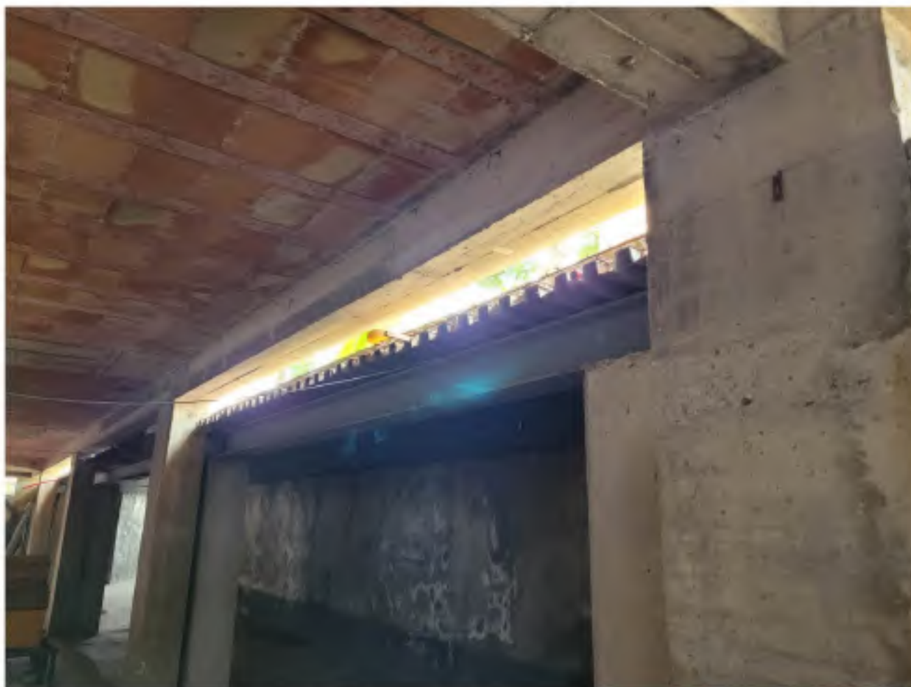
Foto n. 58. Edificio individuato al Catasto Fabbricati dalla particella 516 foglio 10: piano seminterrato allo stato rustico - struttura in cemento armato autonoma rispetto all'edificio principale realizzata in adiacenza con interposizione di giunto tecnico
