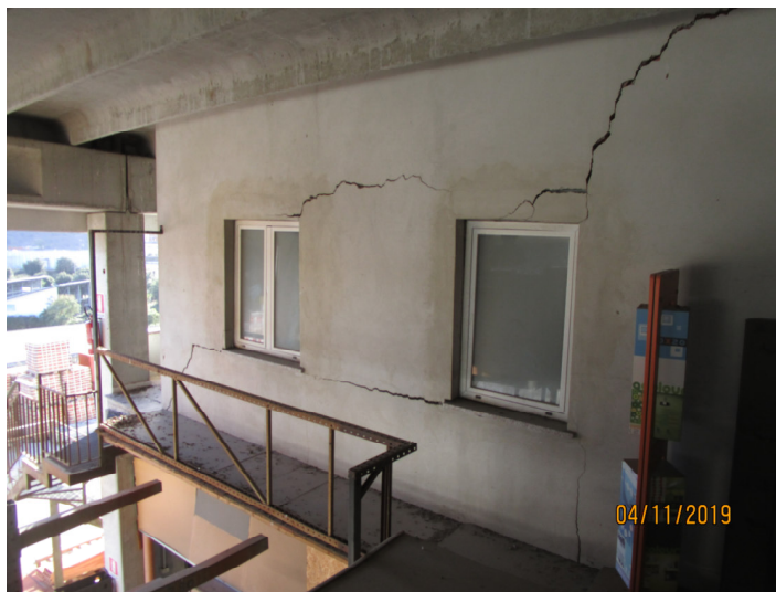
Vista Casa Custode Piano Primo
