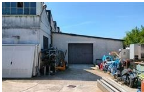
Il piccolo piazzale d'ingresso ed il magazzino
