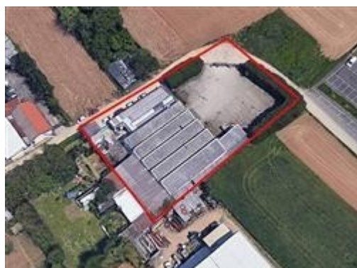
Vista aerea (in rosso il contorno indicativo dell'intera area)
