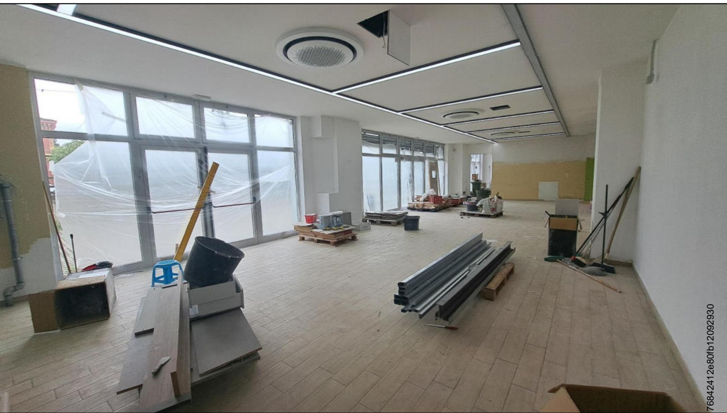
Piano terra ex ristorante/bar
