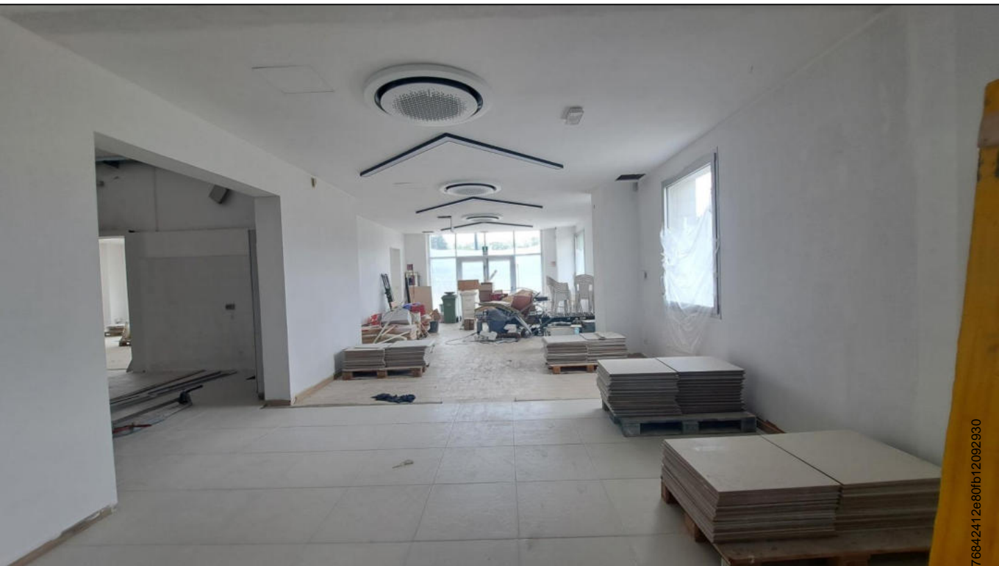
Piano terra ex ristorante/bar
