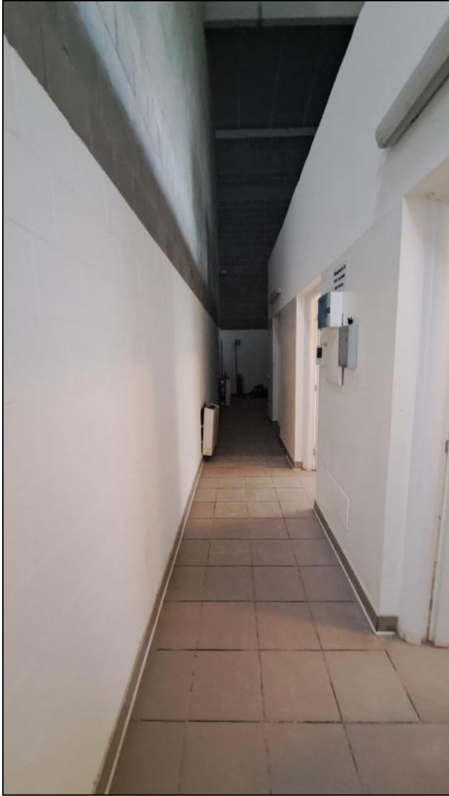
Piano terra disimpegno zona spogliatoi
