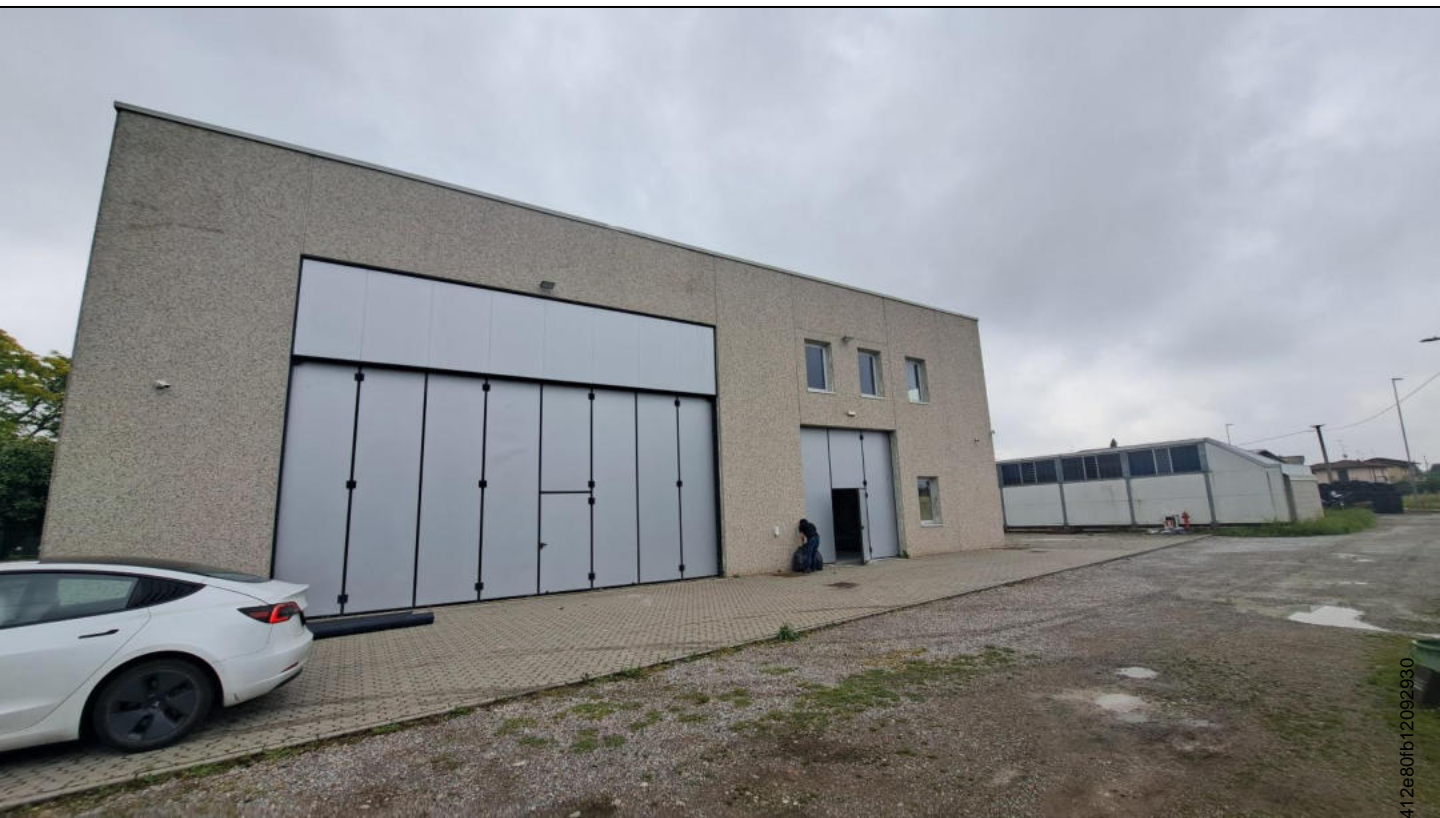
Vista da ingresso da via delle Lavagne- prospetto ovest
