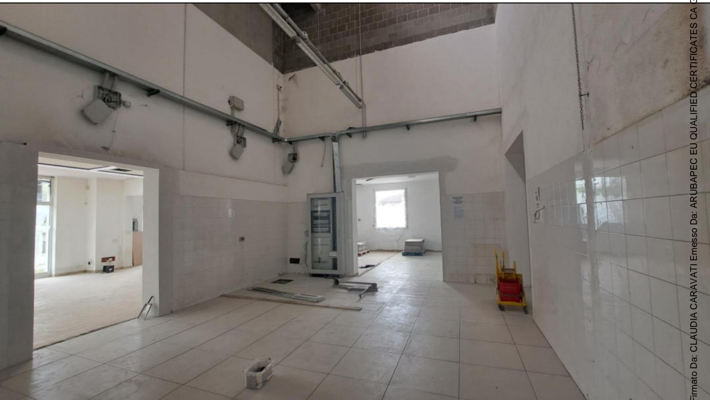
Piano terra ex zona cucina
