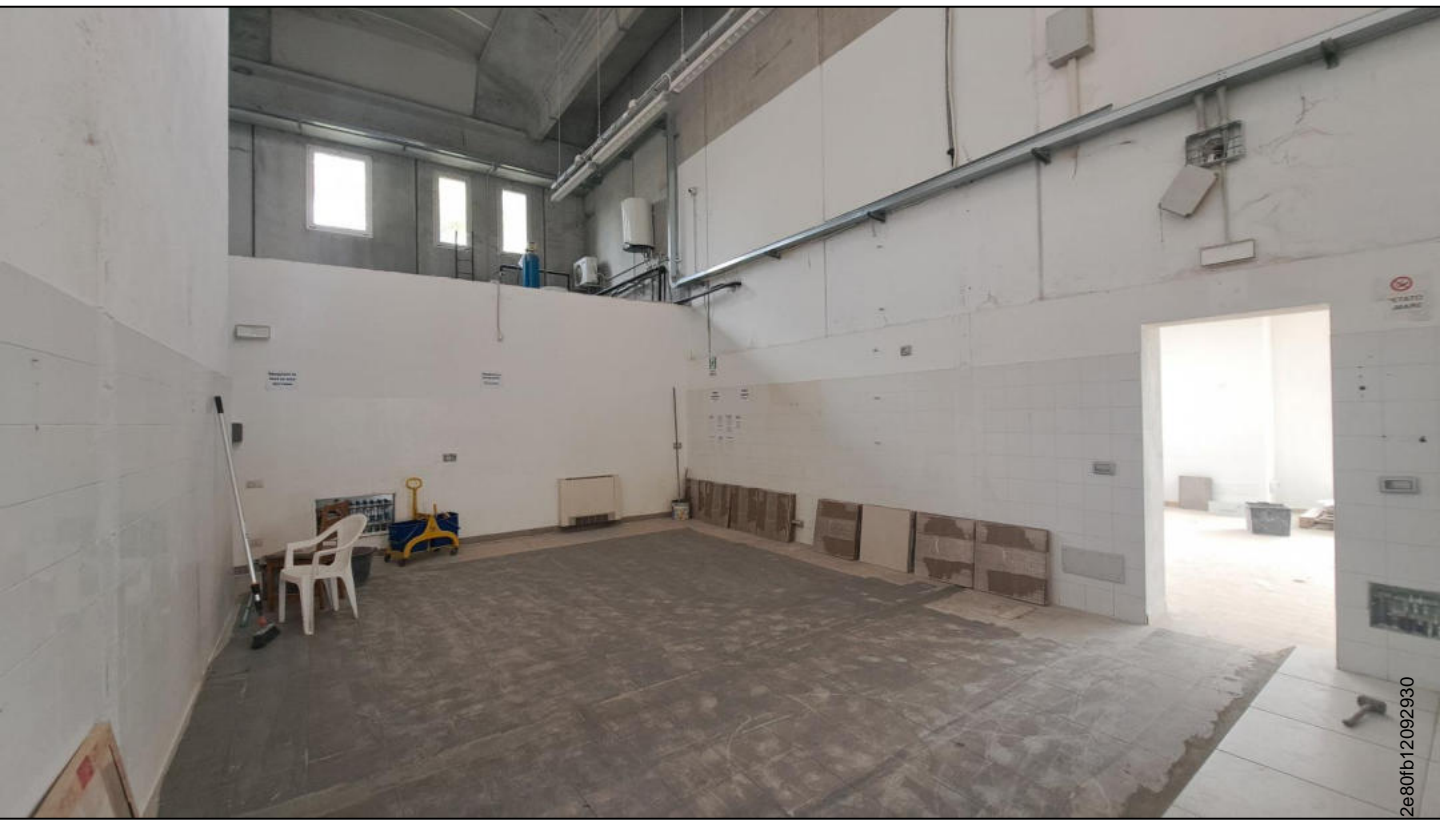
Piano terra ex zona cucina
