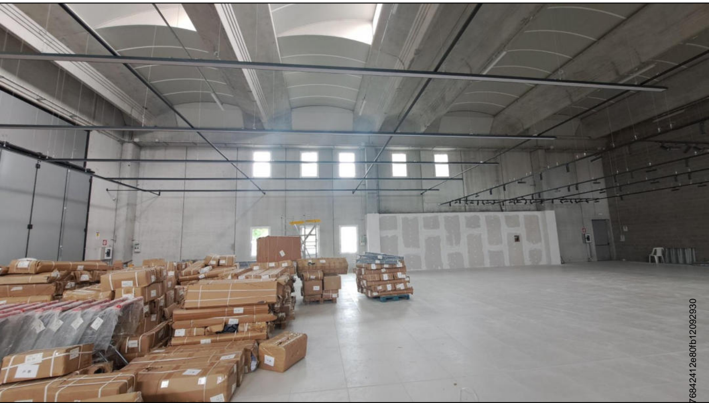
Piano terra capannone
