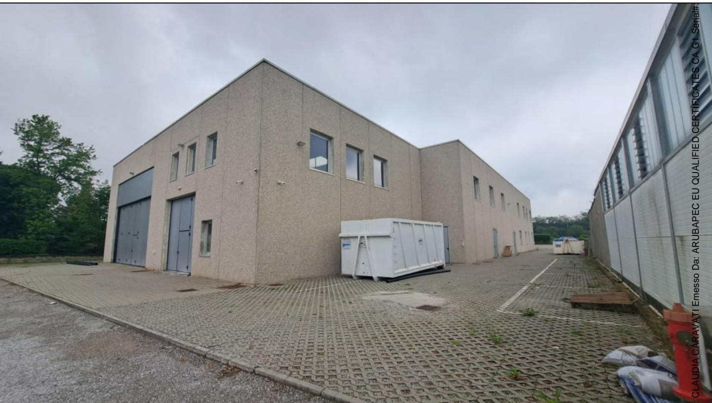
Vista da ingresso da via delle Lavagne – prospetti sud e ovest
