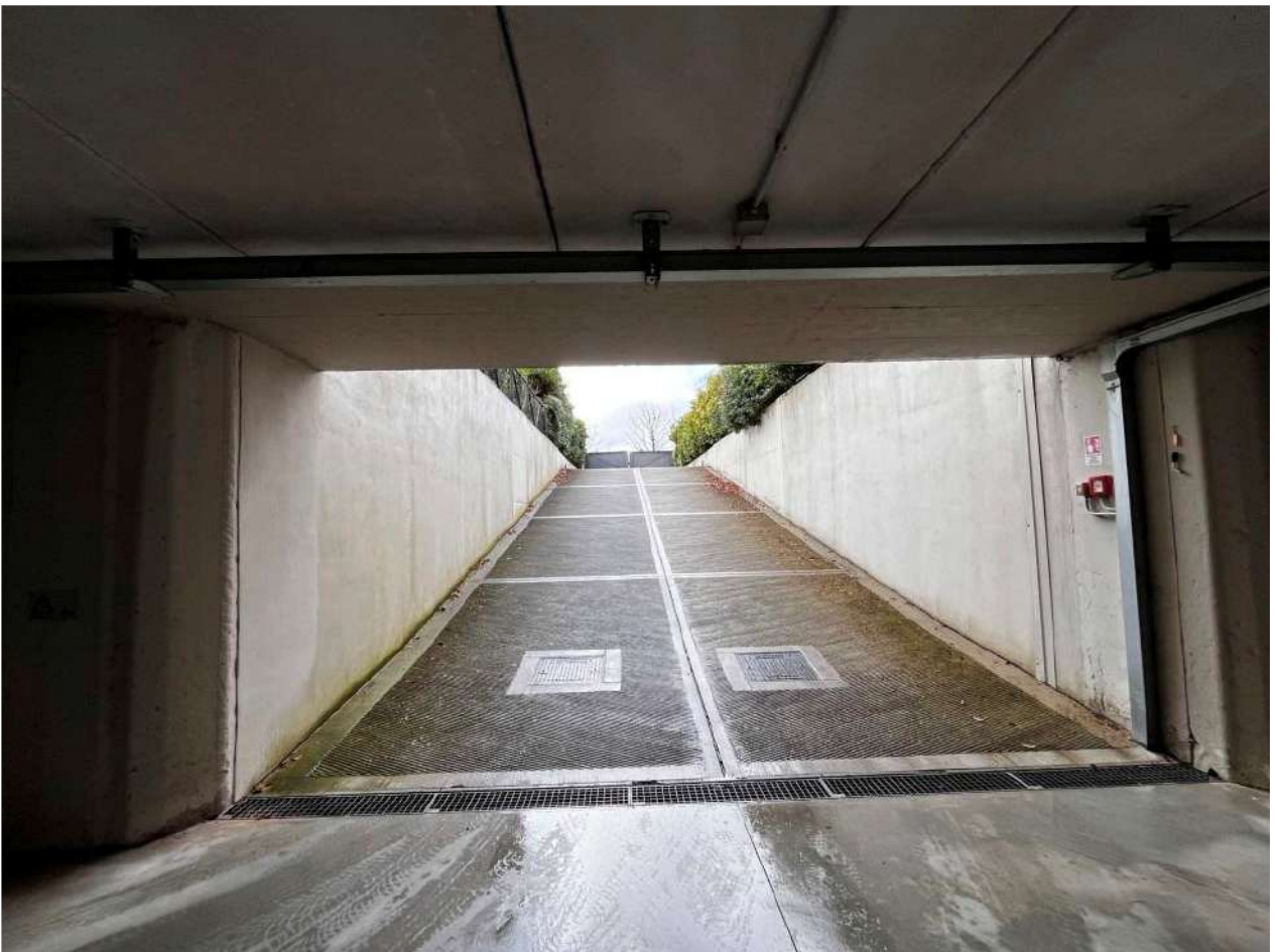
rampa di accesso garage 18
