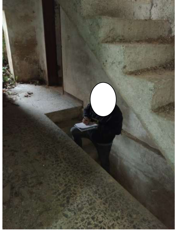
SBARCO SUL PIANO PRIMO
