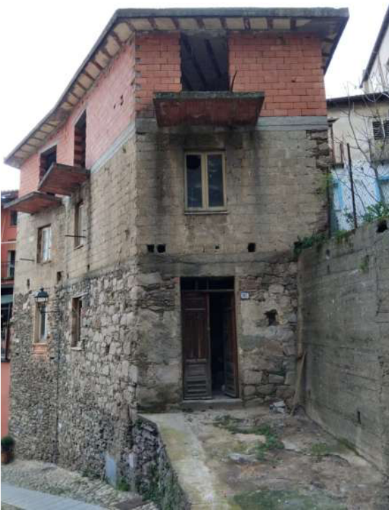
RIPRESA DA VIA MARCONI - ingresso
