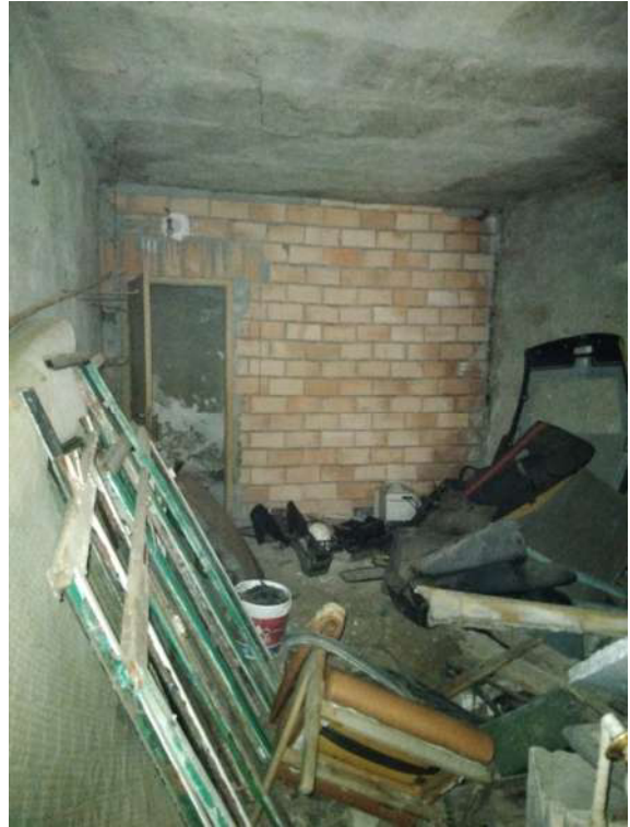
INGRESSO PIANO TERRA
