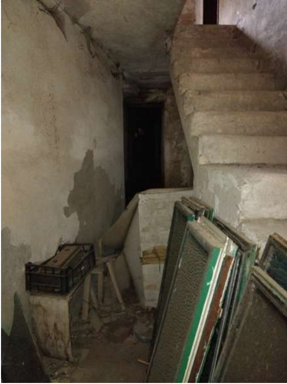
VANO SCALA PIANO TERRA
