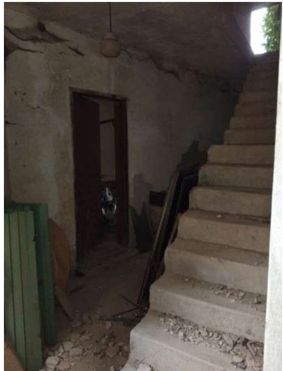
VANO SCALA PIANO TERRA
