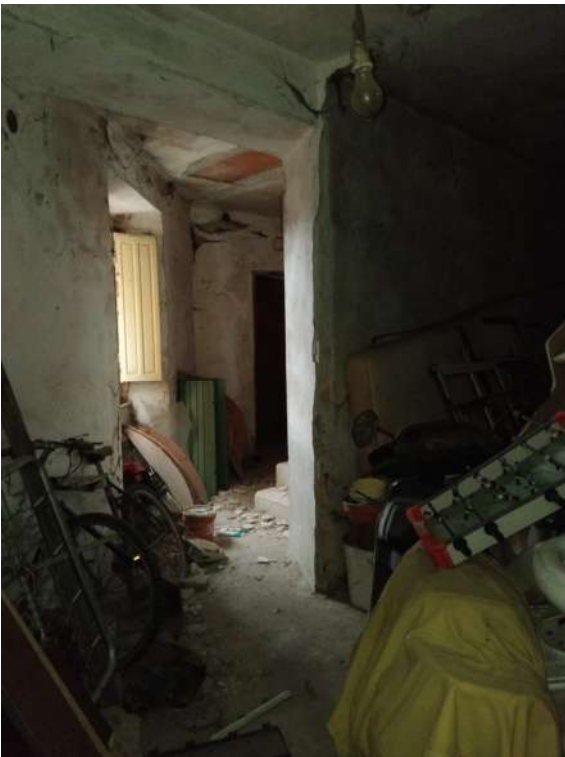
INGRESSO, RIPRESA SUL VANO SCALA
