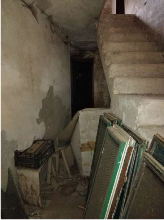
VANO SCALA PIANO TERRA
