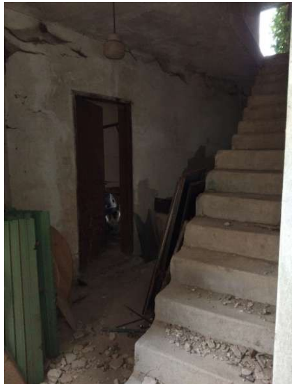
VANO SCALA PIANO TERRA
