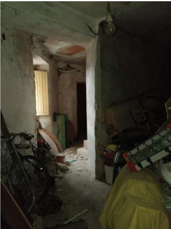
INGRESSO, RIPRESA SUL VANO SCALA
