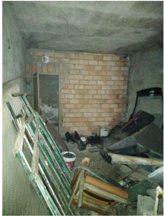
INGRESSO PIANO TERRA
