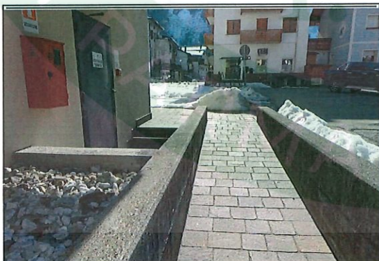
Vista percorsi e ingresso pedonale all'autorimessa
