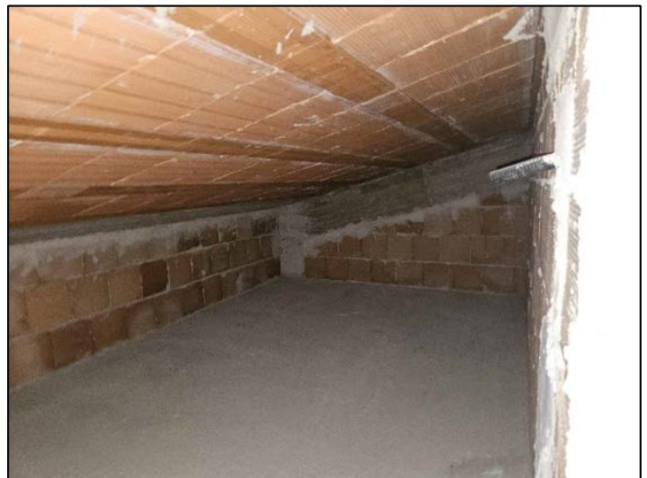
FOTO 21 - Corpo A - Sottotetto
