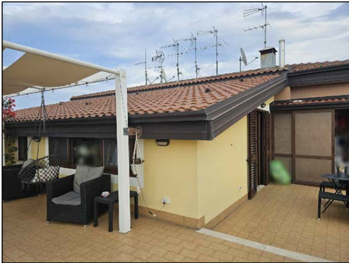
FOTO 18 - Corpo A - Terrazzo
