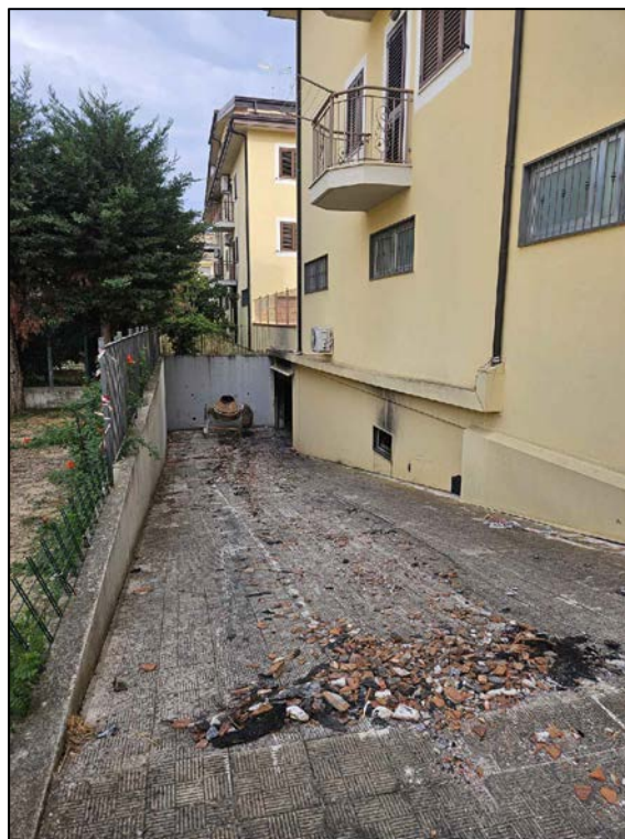
FOTO 26 - Esterni - Rampa di accesso al piano interrato
