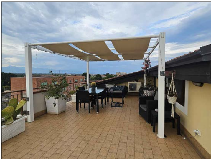
FOTO 20 - Corpo A - Terrazzo e tettoia
