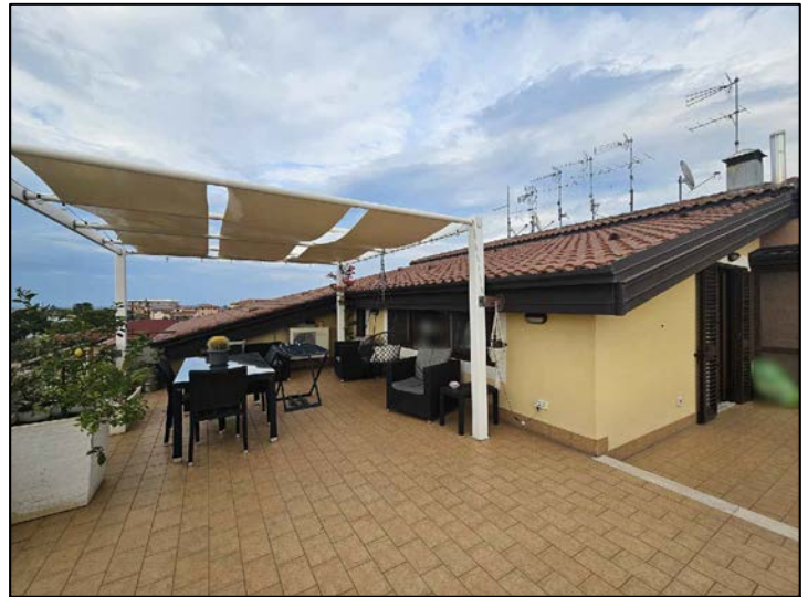
FOTO 19 - Corpo A - Terrazzo e tettoia
