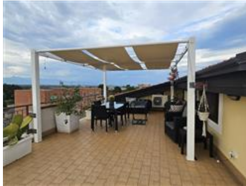
Foto 1 - Tettoia su terrazzo
