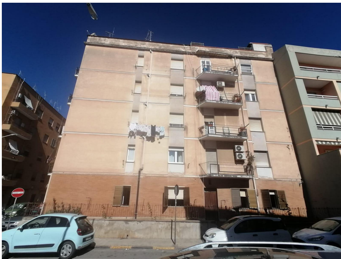
Vista esterno fabbricato
