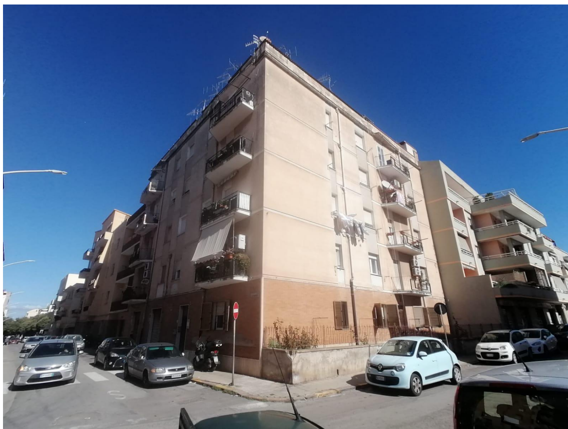
Vista esterno fabbricato
