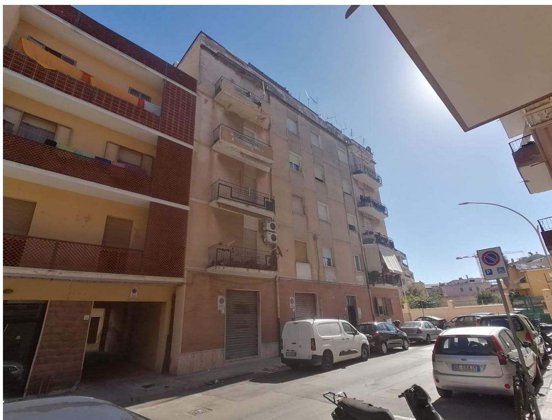
Vista esterno fabbricato
