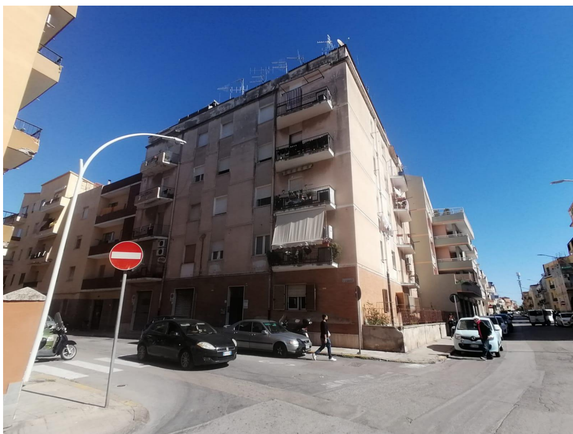
Vista esterno fabbricato
