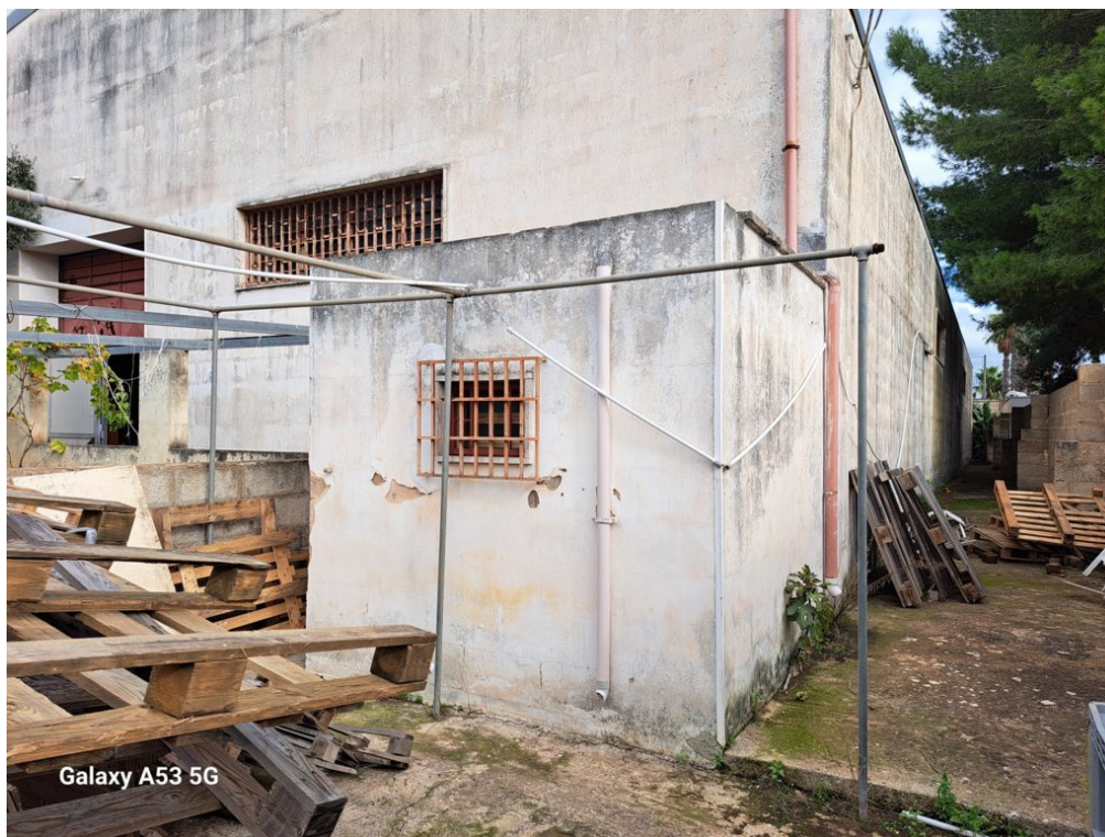
FOTO 5 Passaggio laterale ad area scoperta retrostante il capannone
