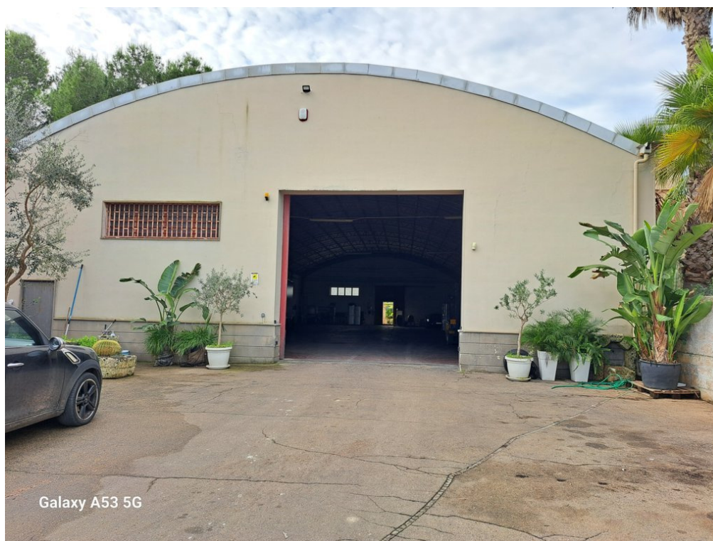
FOTO 2 Spazio di manovra carrabile antistante il capannone autorimessa
