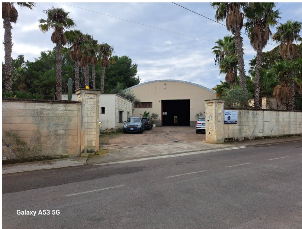
FOTO 1 Str. Prov. Alliste - Torre Suda ingresso al lotto
