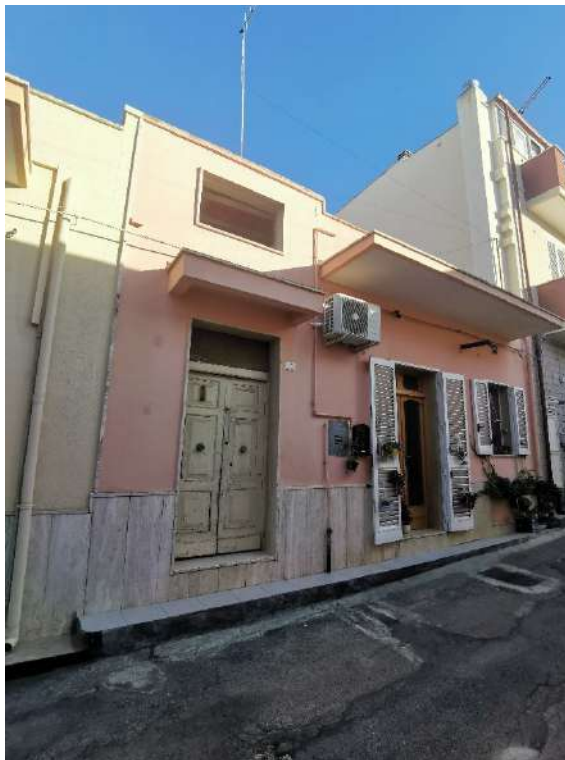
Foto 1: portone di accesso al lastrico solare
