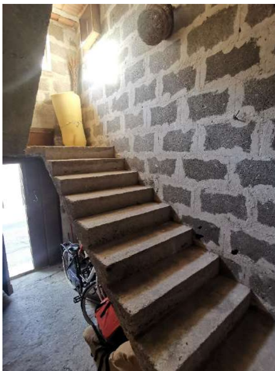
Foto 2: scale di accesso al lastrico solare
