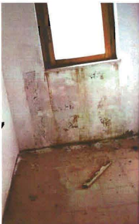
foto n°31 _Particolari ripostiglio 3P
