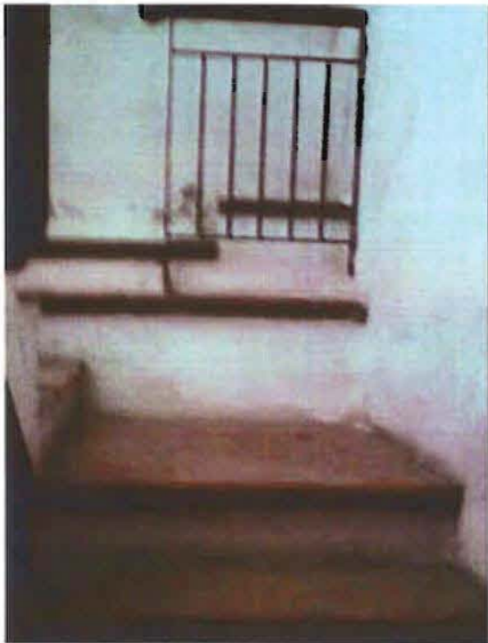
foto n°19_Particolare interno vano scala_PT
