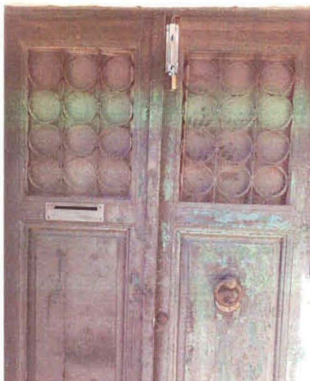
foto n°42 _Particolare chiusura portoncino ingresso
