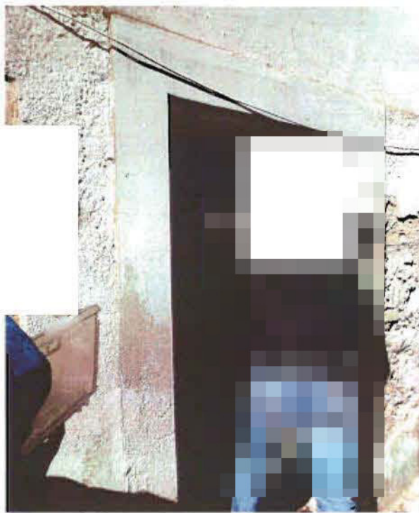
foto n°40 _Particolare chiusura portoncino ingresso
