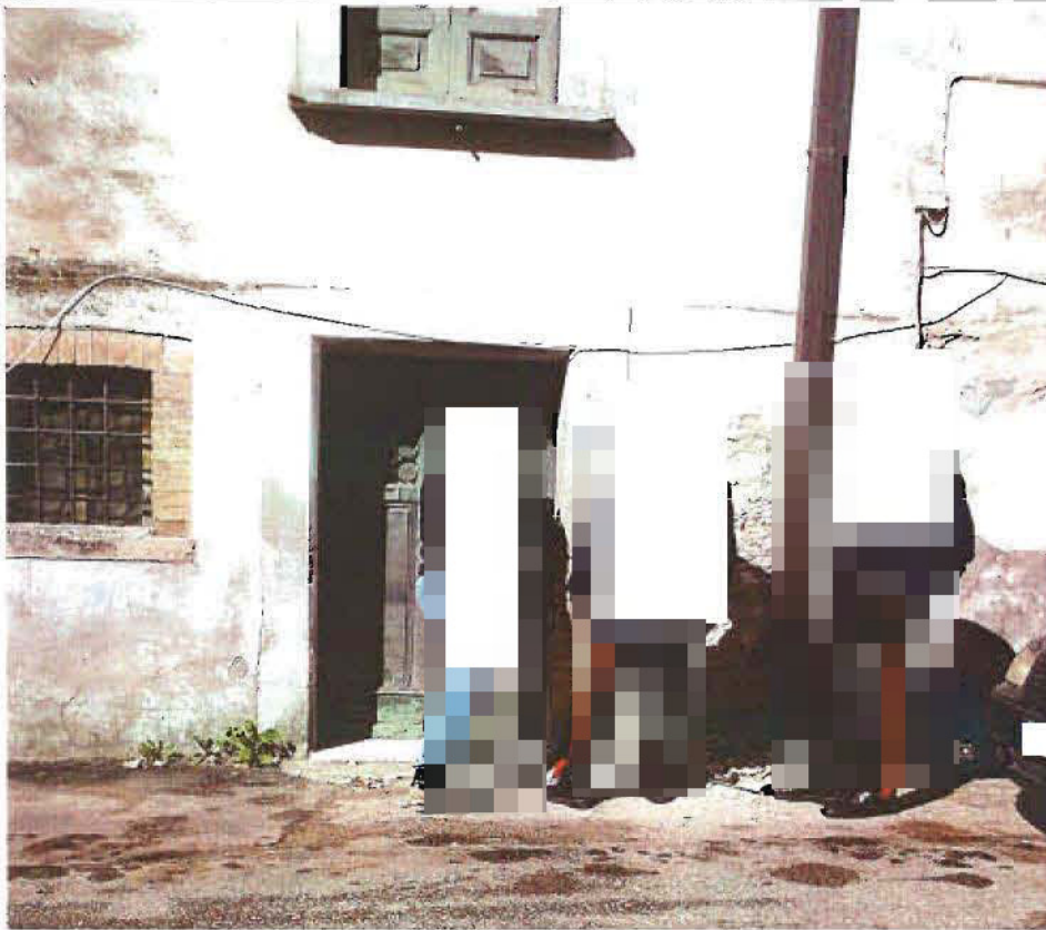
foto n°7_Fase iniziale 2° sopralluogo_Ingresso forzato
