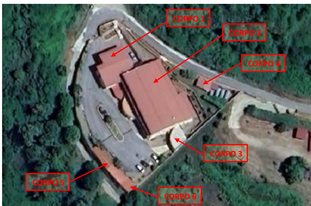
Immagine 3 – Vista aerea della Casa della Speranza con individuazione dei corpi di fabbrica
