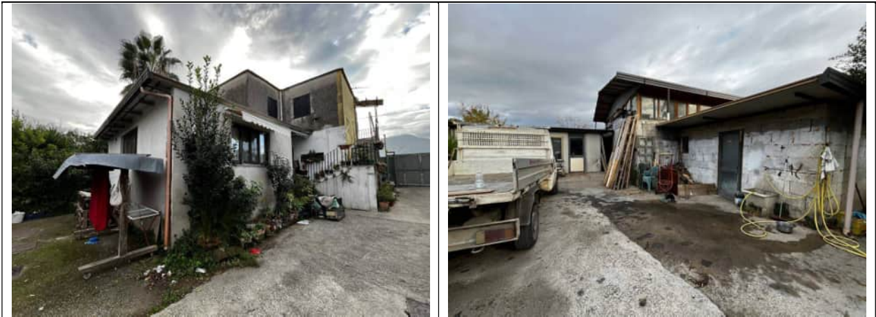
Prospetto principale della porzione di fabbricato e vista della corte esterna su cui insistono i manufatti privi di titolo abilitativo.
