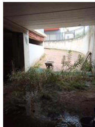
Rampa di accesso B all'interrato
