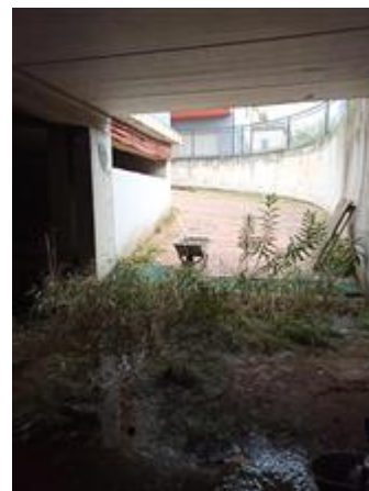
Rampa di accesso B all'interrato
