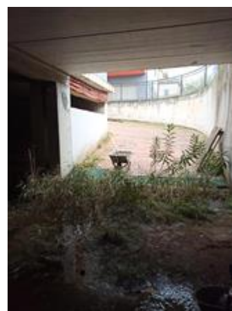
Rampa di accesso B all'interrato
