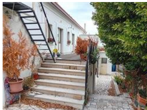
Scala di accesso al terrazzo
