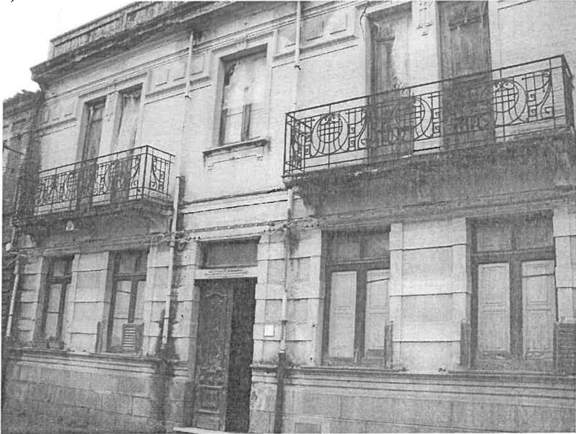
Foto n. 01: Prospetto principale (p. 109)
