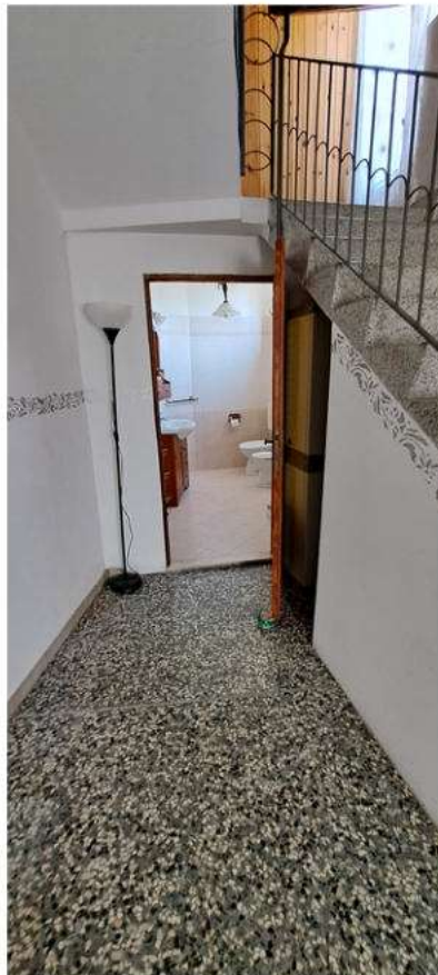
13_vano scala corridoio
