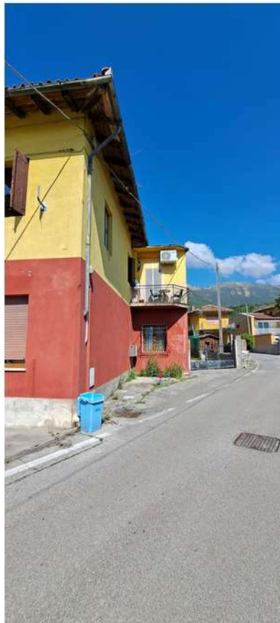
E4_ fronte sud
