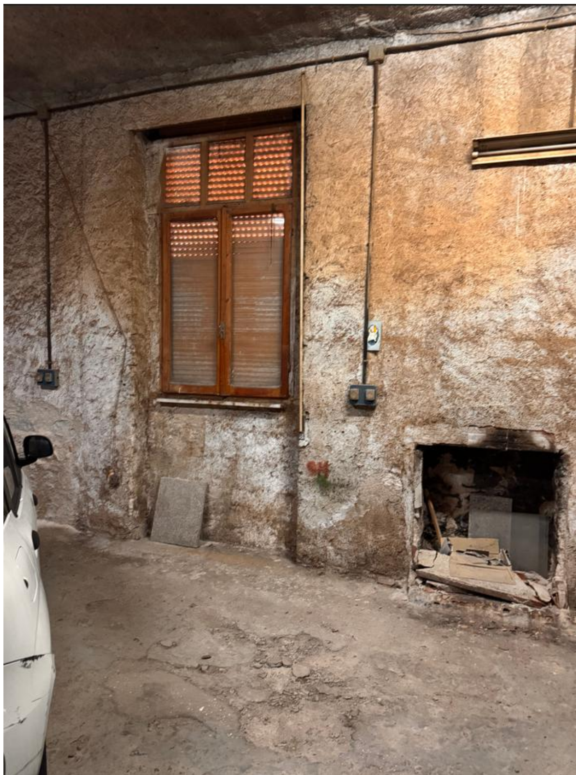
Foto 15: finestra nel garage lato nord
