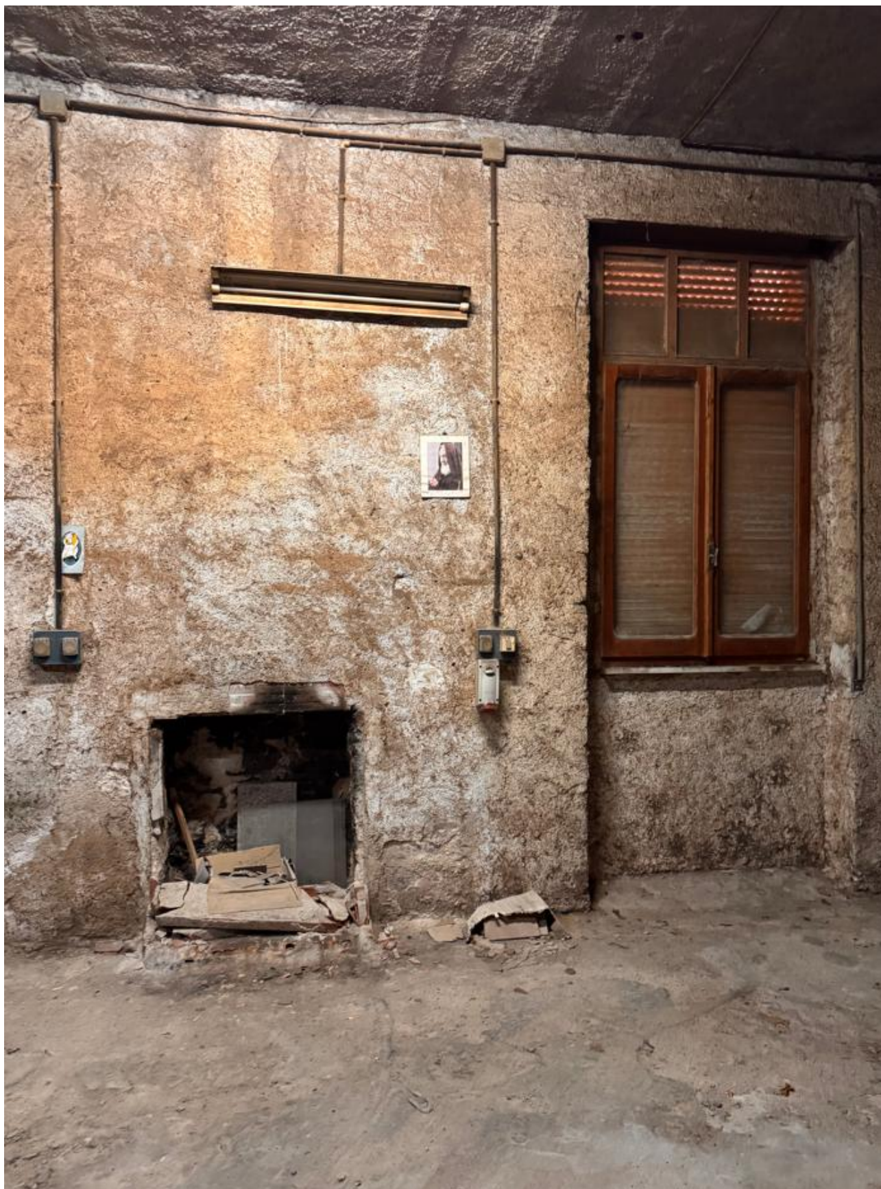
Foto 16: Finestra del garage lato ovest
