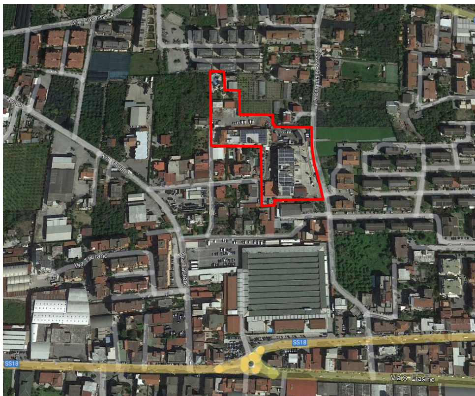
Vista satellitare del complesso staggito e dei beni immobili al contorno (cfr. Allegato 4.1)
