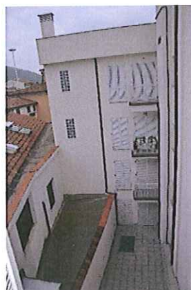
Vista cortile interno
