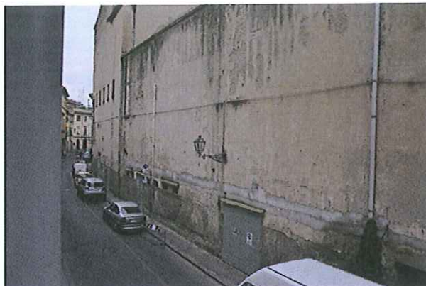
Vista da loggia del soggiorno
