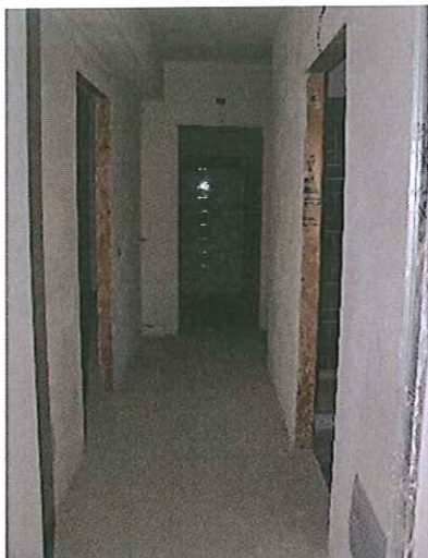
Corridoio reparto notte
