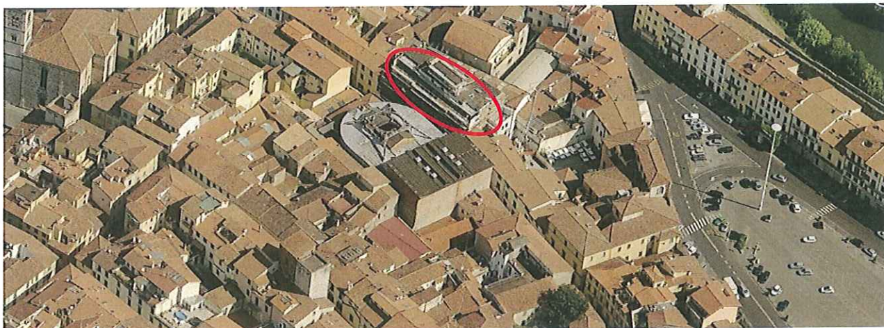
Ubicazione del fabbricato, vista dall'alto 3D
