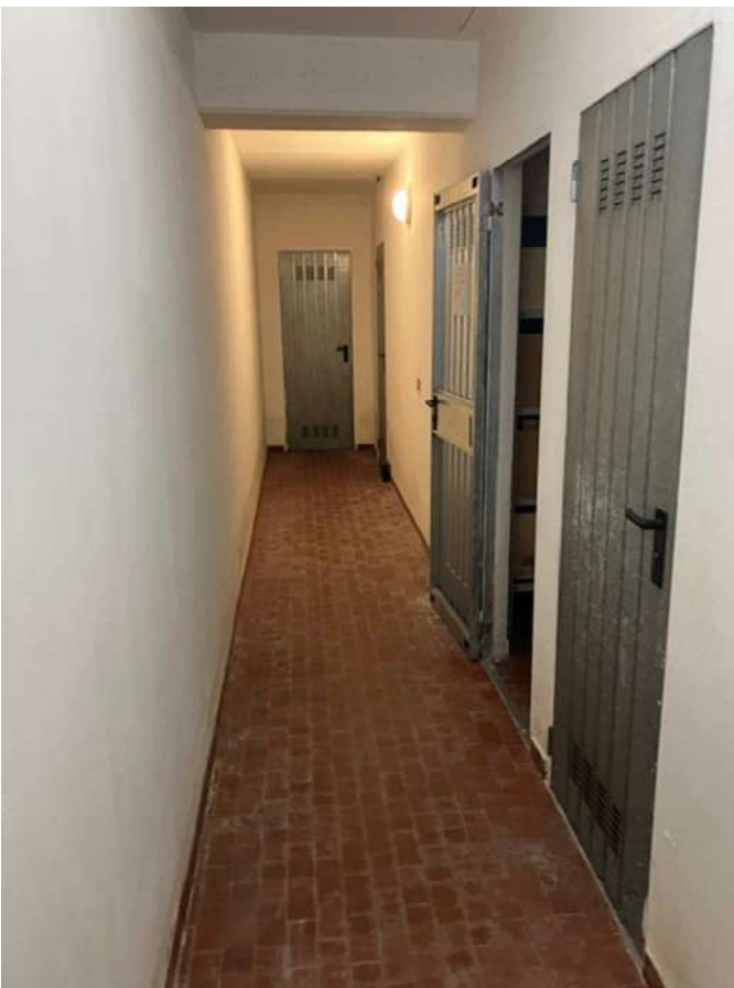
Parti comuni – Corridoio accesso cantina
