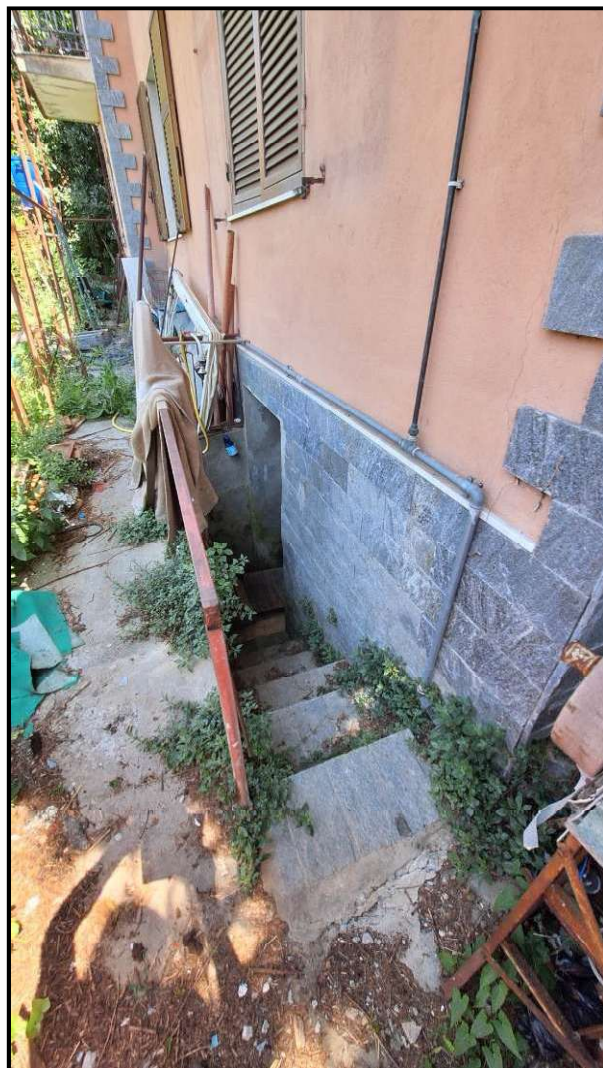
FOTO N. 18 – Accesso alla cantina interrata
