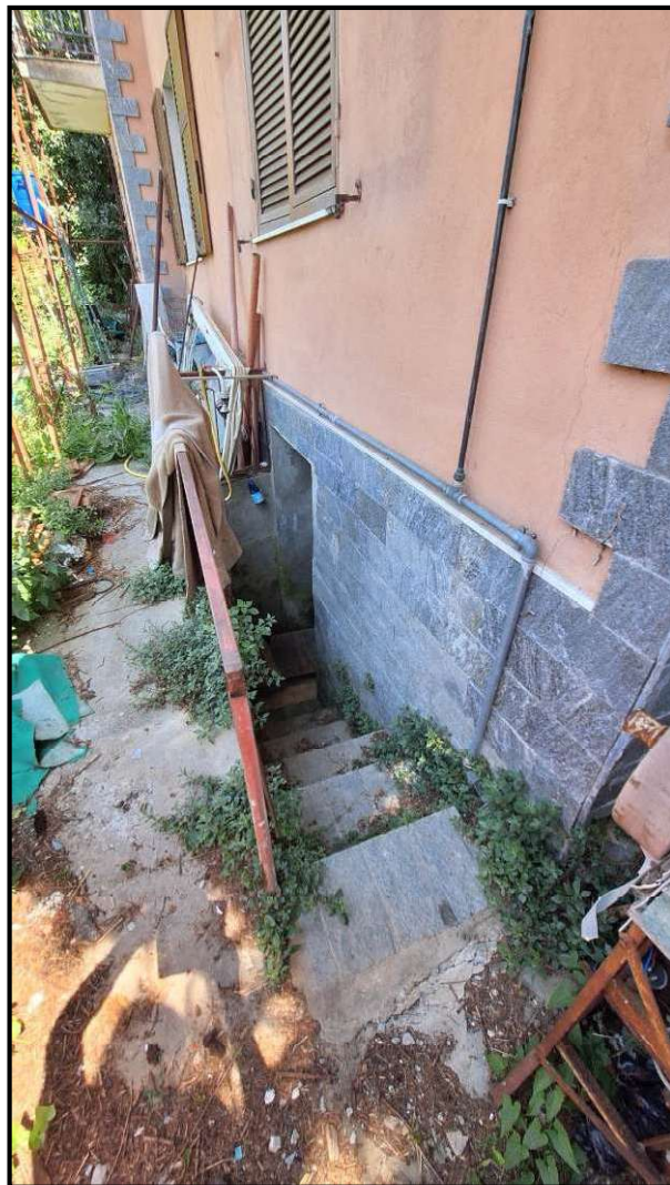
FOTO N. 18 – Accesso alla cantina interrata
