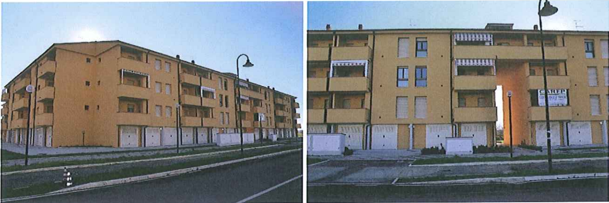
Prospetto su via Fellini, a piano terra si notano le saracinesche dei box auto
