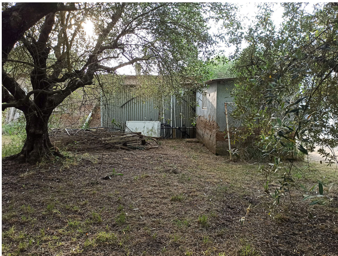
Foto n. 30 - dettaglio dei fabbricati C (pollaio/porcilaia) con copertura in cemento amianto, la muratura in pietra di tufo e travi in legno e E (deposito/autorimessa) con copertura in solaio di latero-cemento e tegole di laterizi Foto n.31- vista del cortile con i fabbricati realizzati senza autorizzazione
