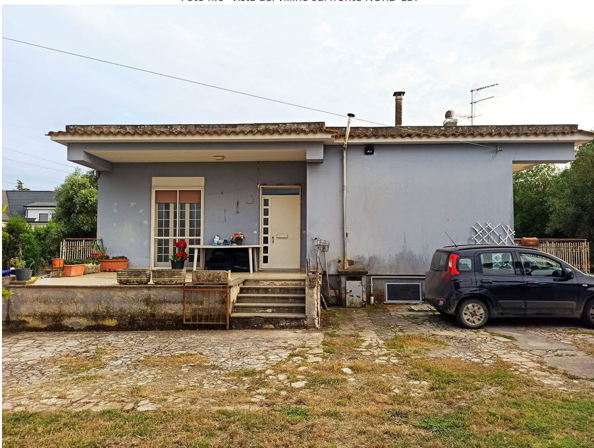
Foto n.6- vista del villino sul fronte NORD-EST
