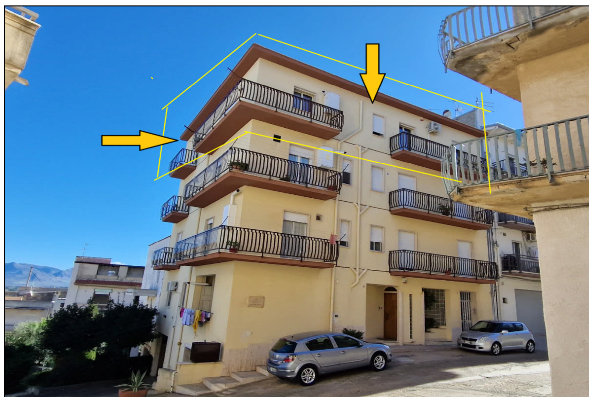
Foto 2: Panoramica esterna – fabbricato urbano via G. Mistretta di Paola n. 4 Alcamo
