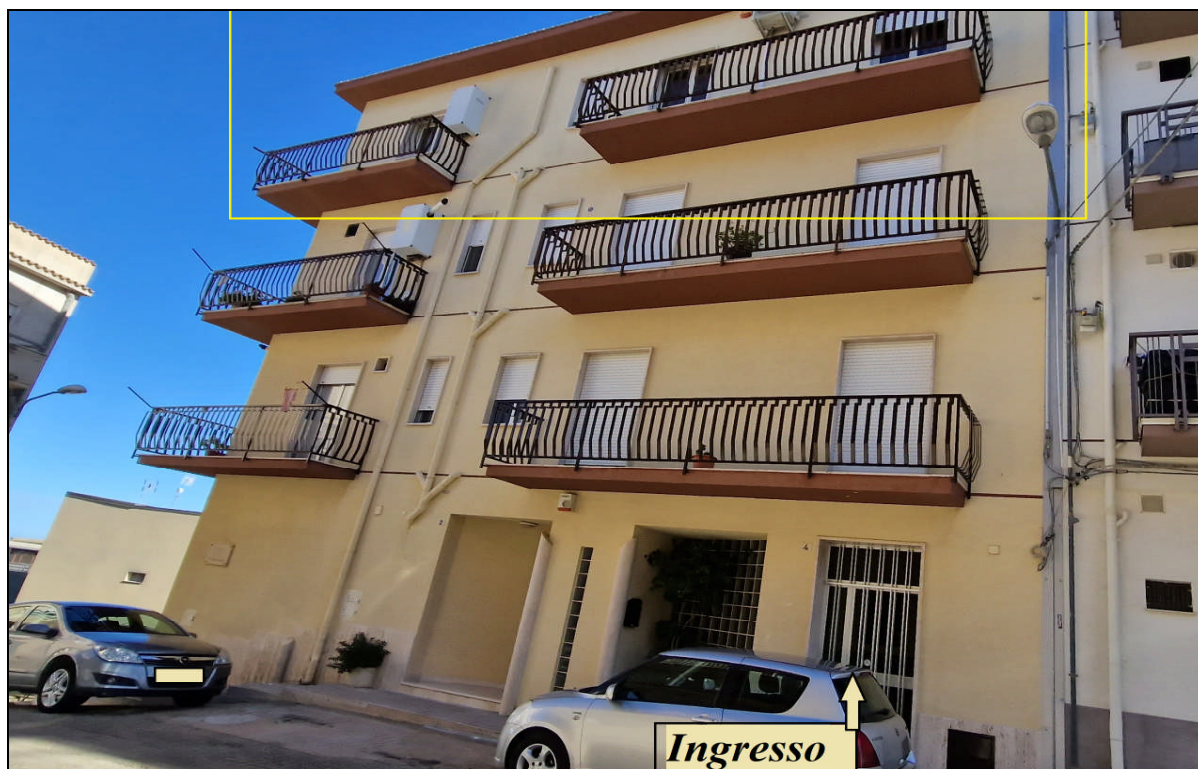
Foto 3: Panoramica esterna – fabbricato urbano via G. Mistretta di Paola n. 4 Alcamo
