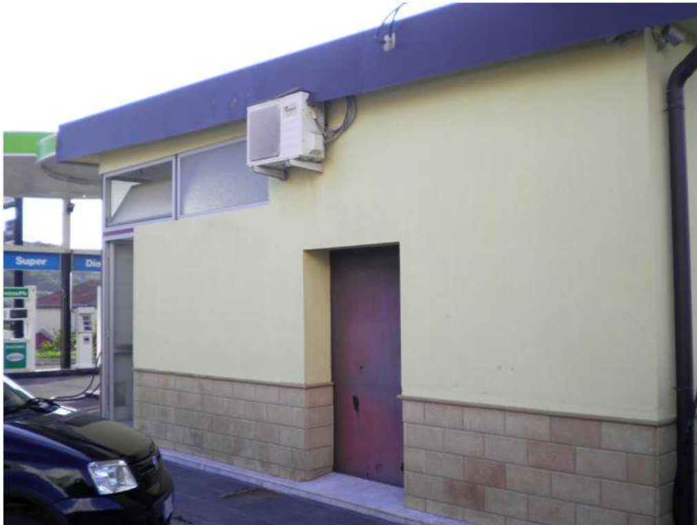
Figura 10 - Foto esterna locale deposito
