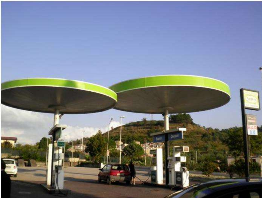
Figura 4 - Foto esterna impianto dei carburanti
