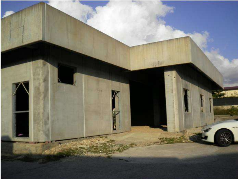
Figura 6 - Foto esterna capannone in corso di costruzione
