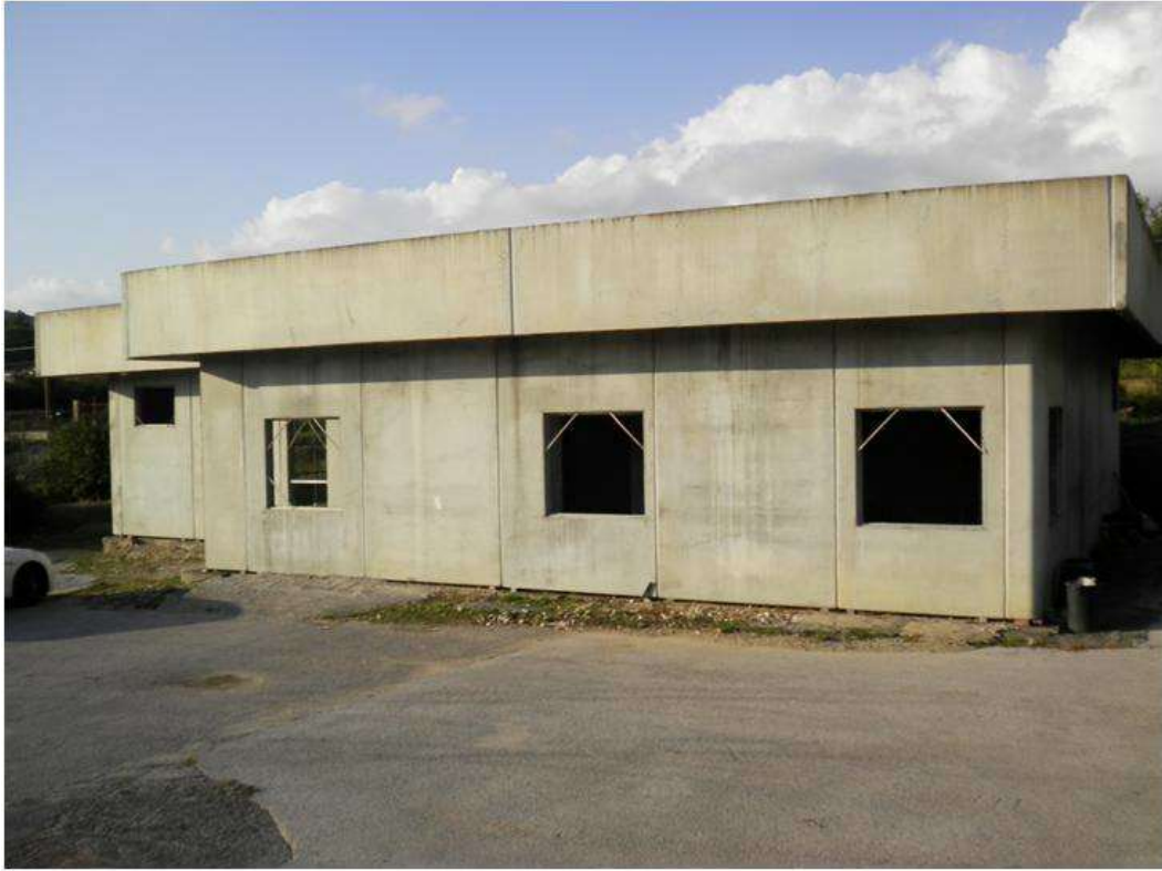
Figura 5 - Foto esterna capannone in corso di costruzione
