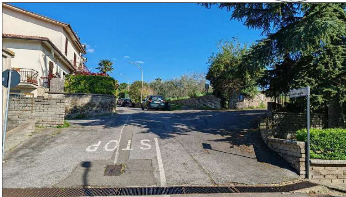
foto 1 - vista dalla strada d'accesso del fabbricato ove sono posti i beni pignorati.
