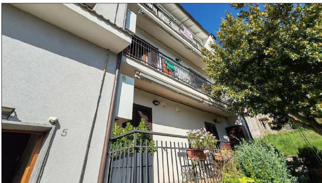
foto 8 - dettaglio dell'ingresso al vano scala e del balcone dell'abitazione al piano 1° sul prospetto sud.
