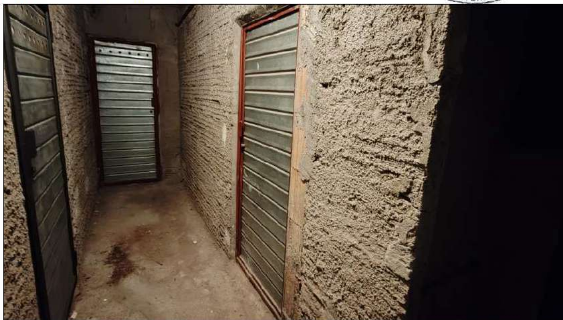
foto 9 - vista del corridoio comune al p.S1 con l'accesso pedonale al deposito pertinenziale all'abitazione.
