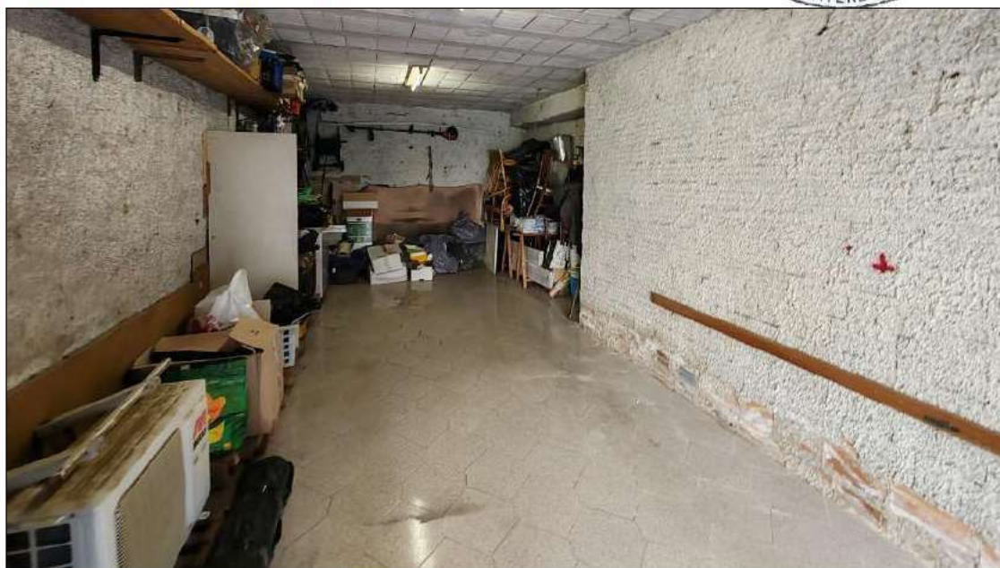
foto 11 - vista interna del locale rimessa con entrostante locale deposito.
