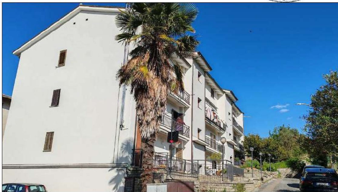
foto 3 - vista d'insieme da ovest della palazzina.
