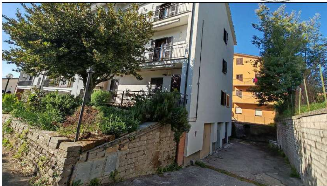
foto 5 - vista d'insieme da sud-est dell'edificio.
