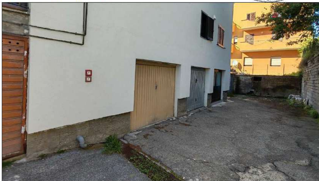
foto 7 - dettaglio dell'accesso carrabile al locale rimessa al p. S1 sul prospetto est.
