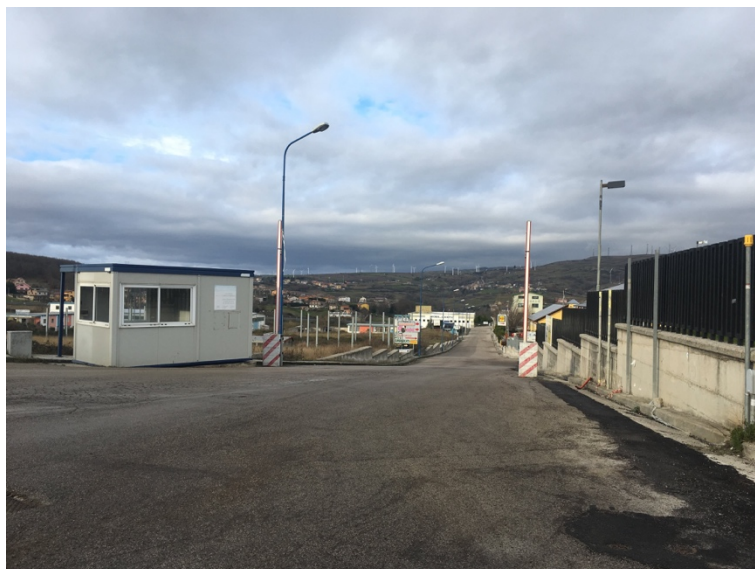
Accesso all' area industriale dalla s.s.169
