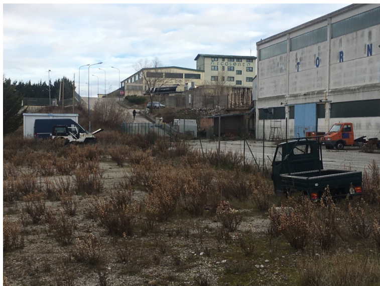
Vista interna all'area
