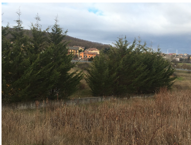
Recinzione a confine con la p.lla 418
