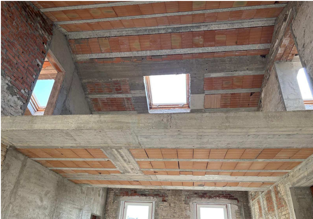
FOTO N. 10 SOTTOTETTO (PORZIONE CHE SI AFFACCIA SU SOGGIORNO)
