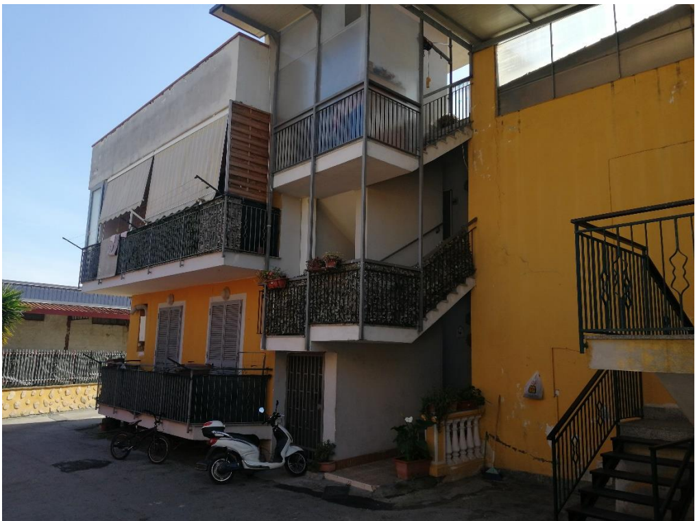
Prospetto nord dell'edificio in Scafati al f. 4, part. 285
