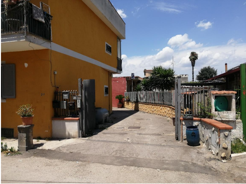
Accesso al cortile in via Berardinetti, I traversa Baracconi, n.27
