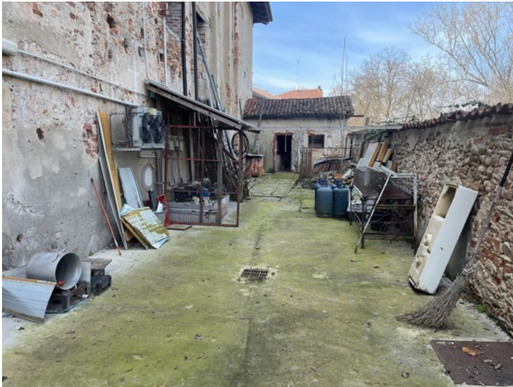
Fotografia A.96 - FOTO AREA PERTINENZIALE RETRO EDIFICIO (SUB. 15 - LOTTO 3)
