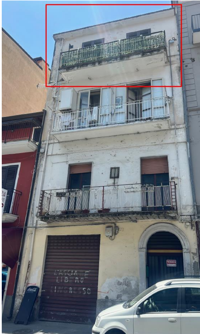
FOTO 1 – Prospetto Sud-Ovest (Via Indipendenza)
