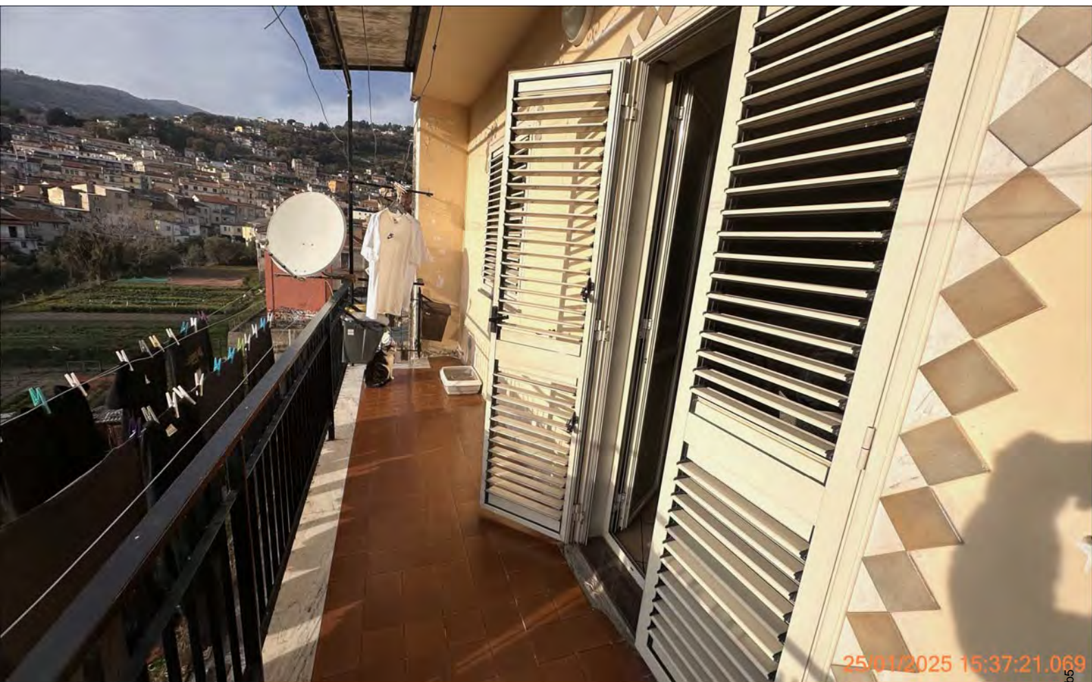
19 terrazzo cucina lato sud ovest.jpg
