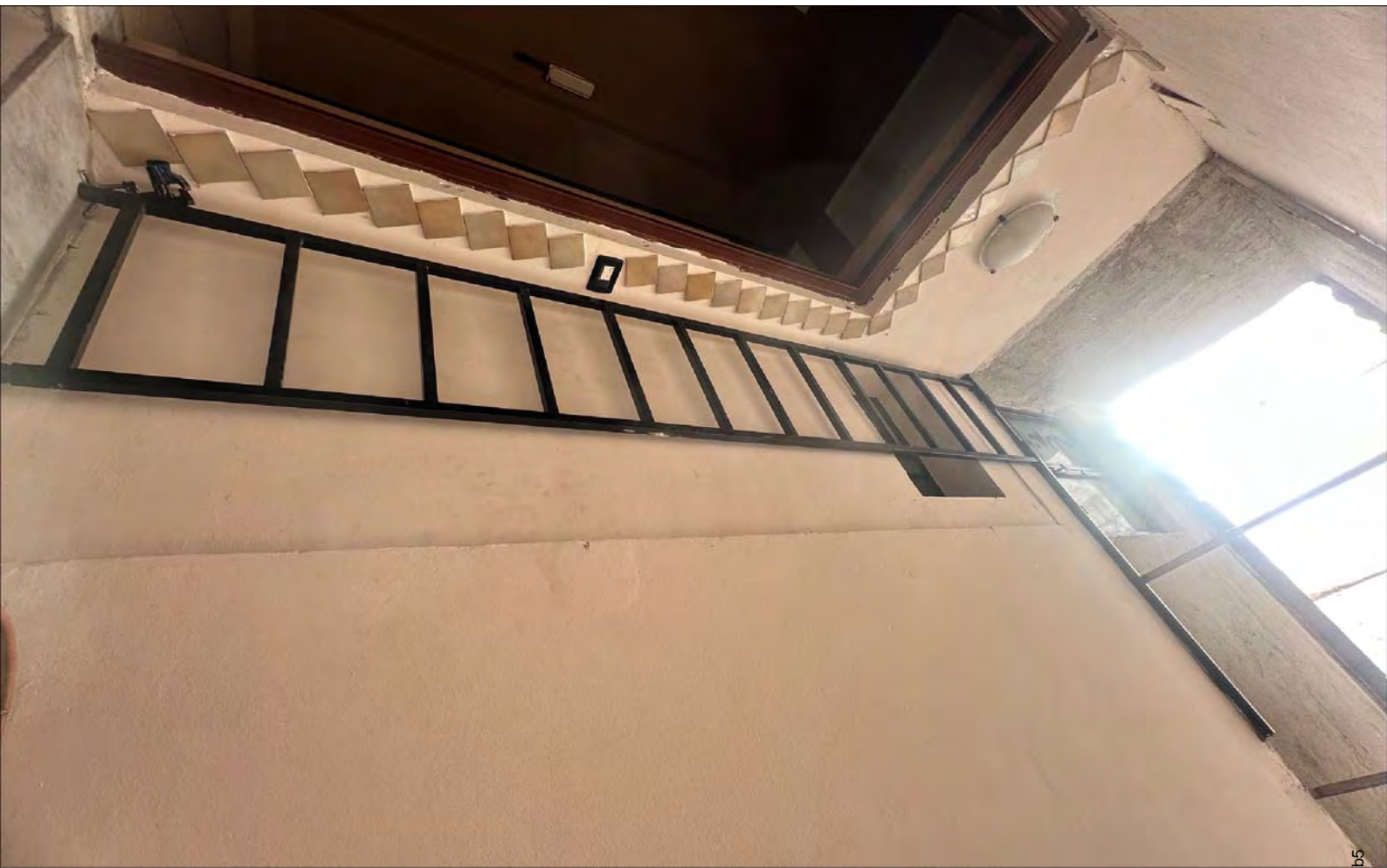
5 accesso al sottotetto dal vano scala.jpg
