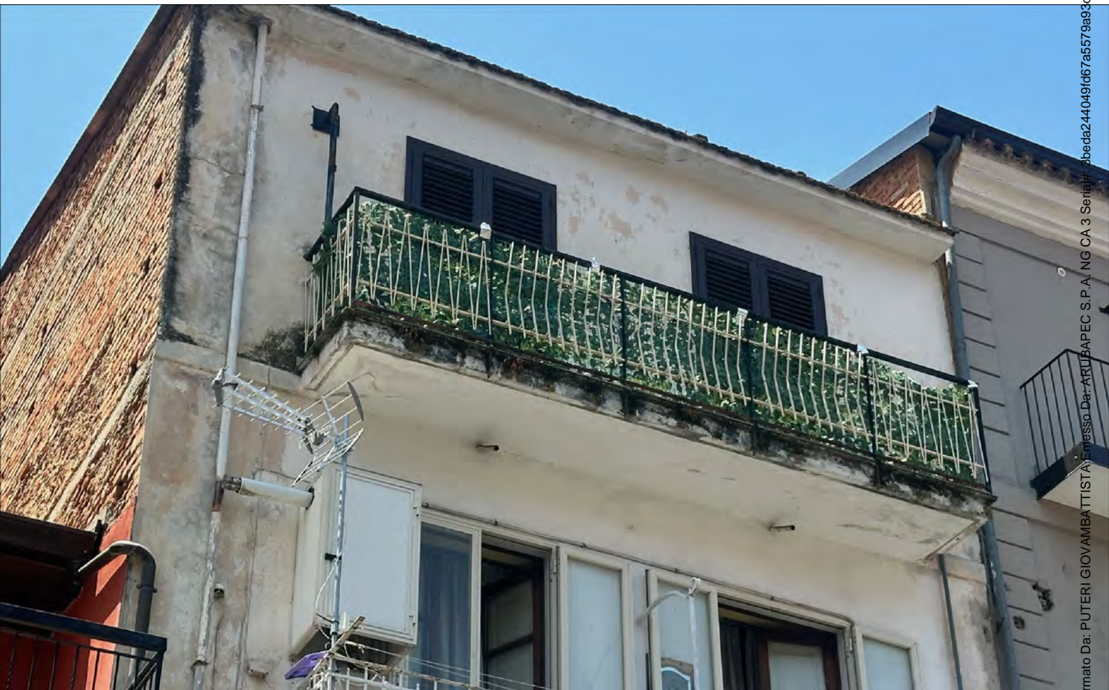
2 particolare terzo piano.jpg
