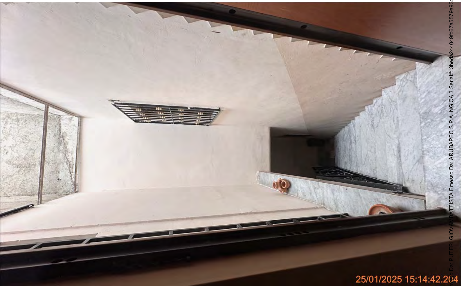
6 rampa d'accesso all'immobile del terzo piano.jpg
