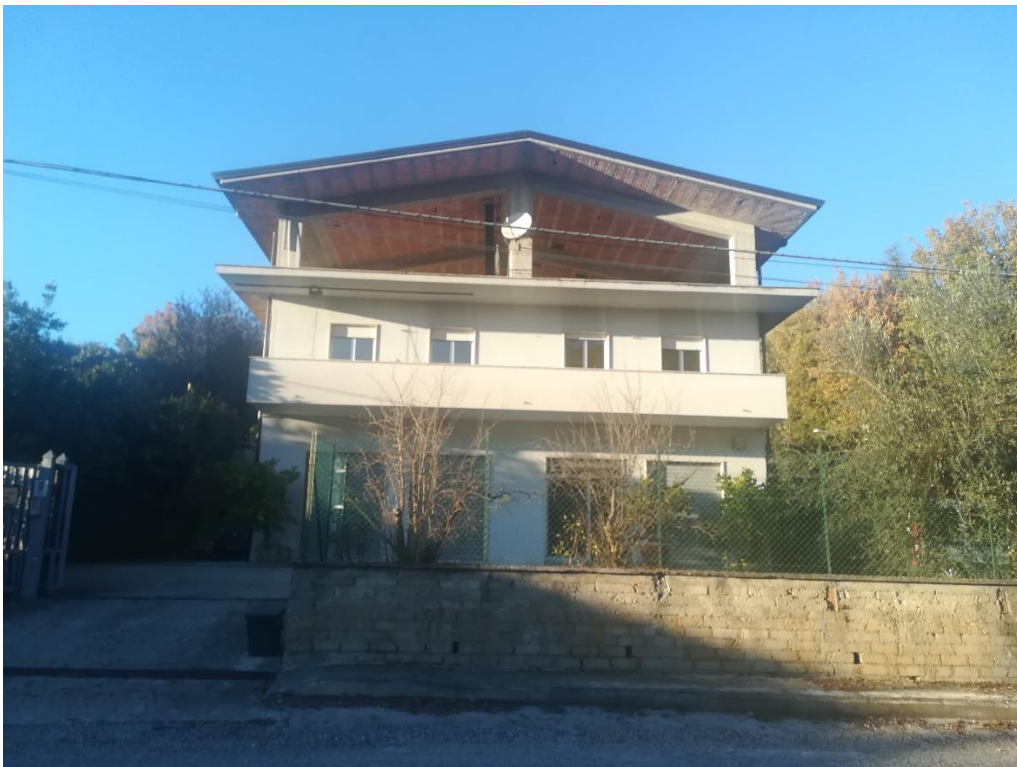
LATO SUD ACCESSO SU VIA FIUME
