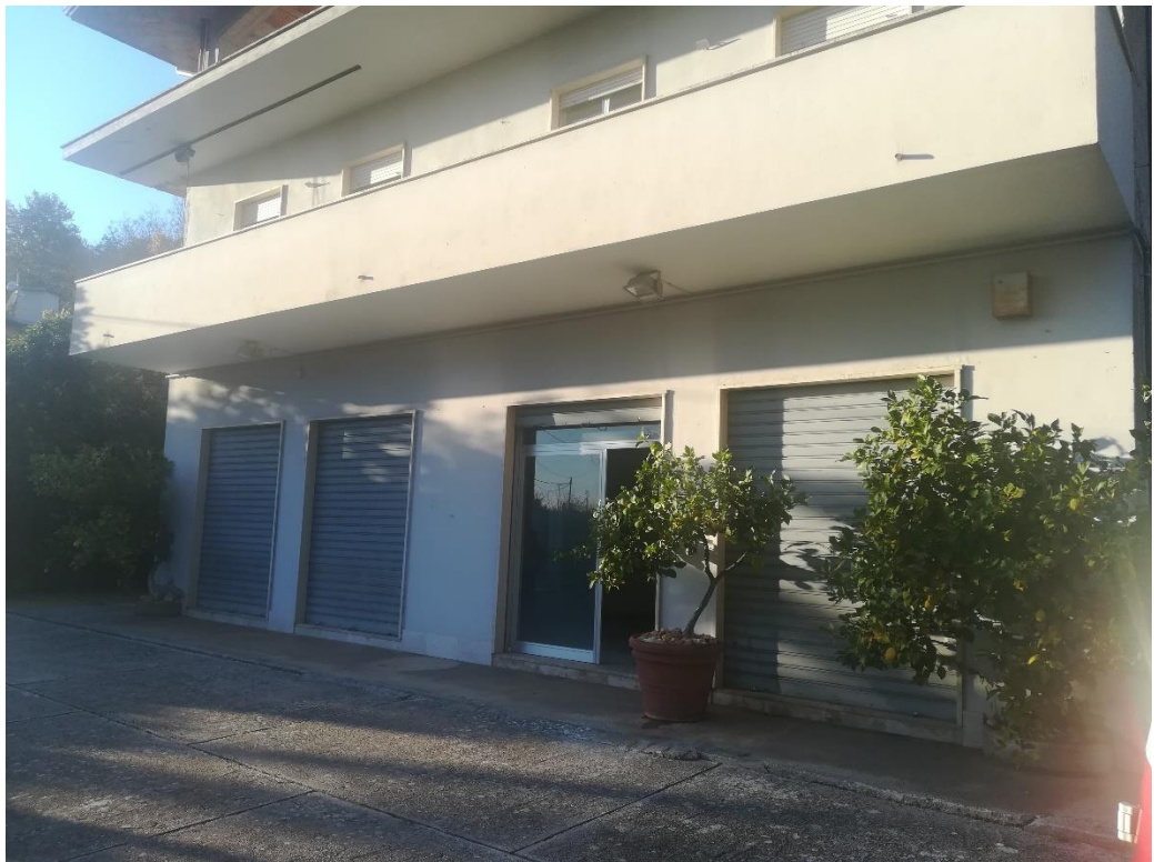
INGRESSO LOCALE LATO SUD
