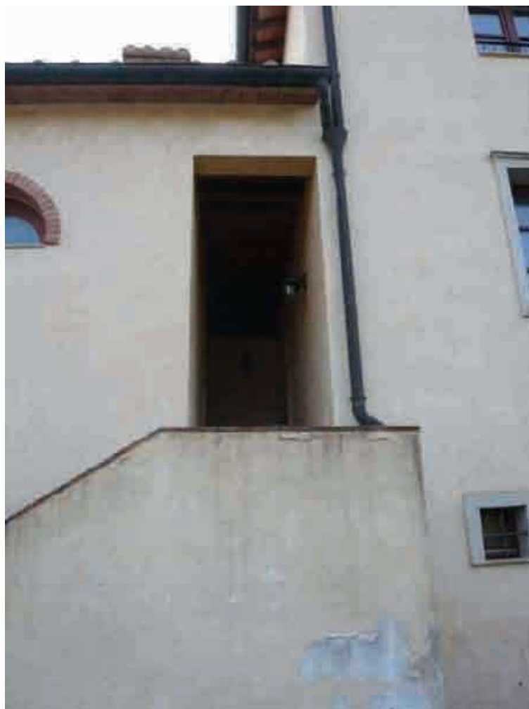
scala condominiale di accesso
