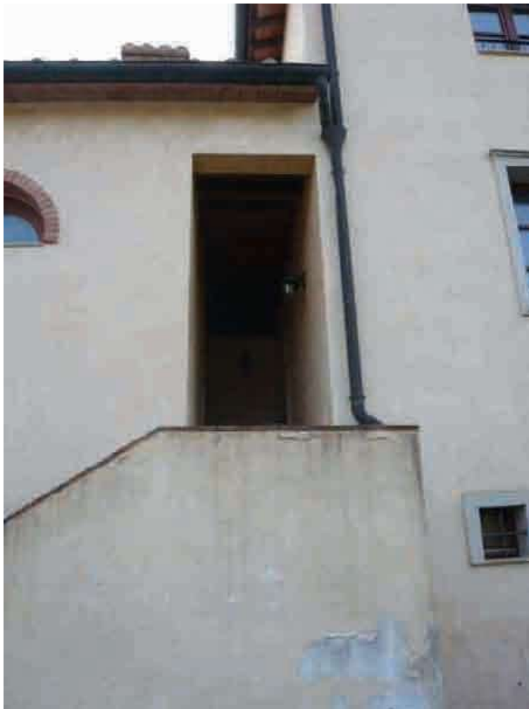
scala condominiale di accesso
