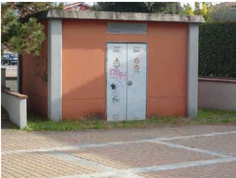
cabina elettrica - accesso
