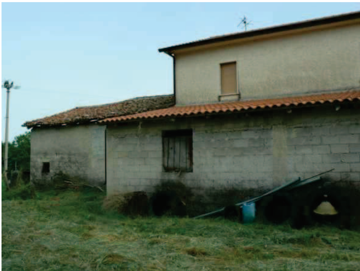
Figura 3 - loc. Policeta - Foglio 16 part. 706 sub 3 (abitazione e cantina) e a sinistra sub 4 (fienile)
