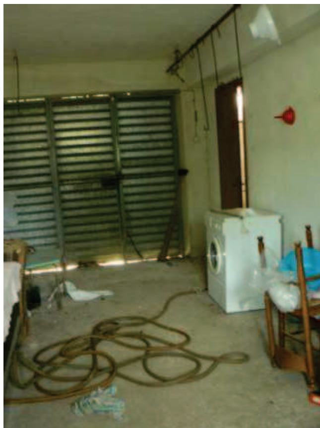
Figura 14 – Loc. Policeta - Foglio 16 part. 706 sub. 3 piano terra - deposito
