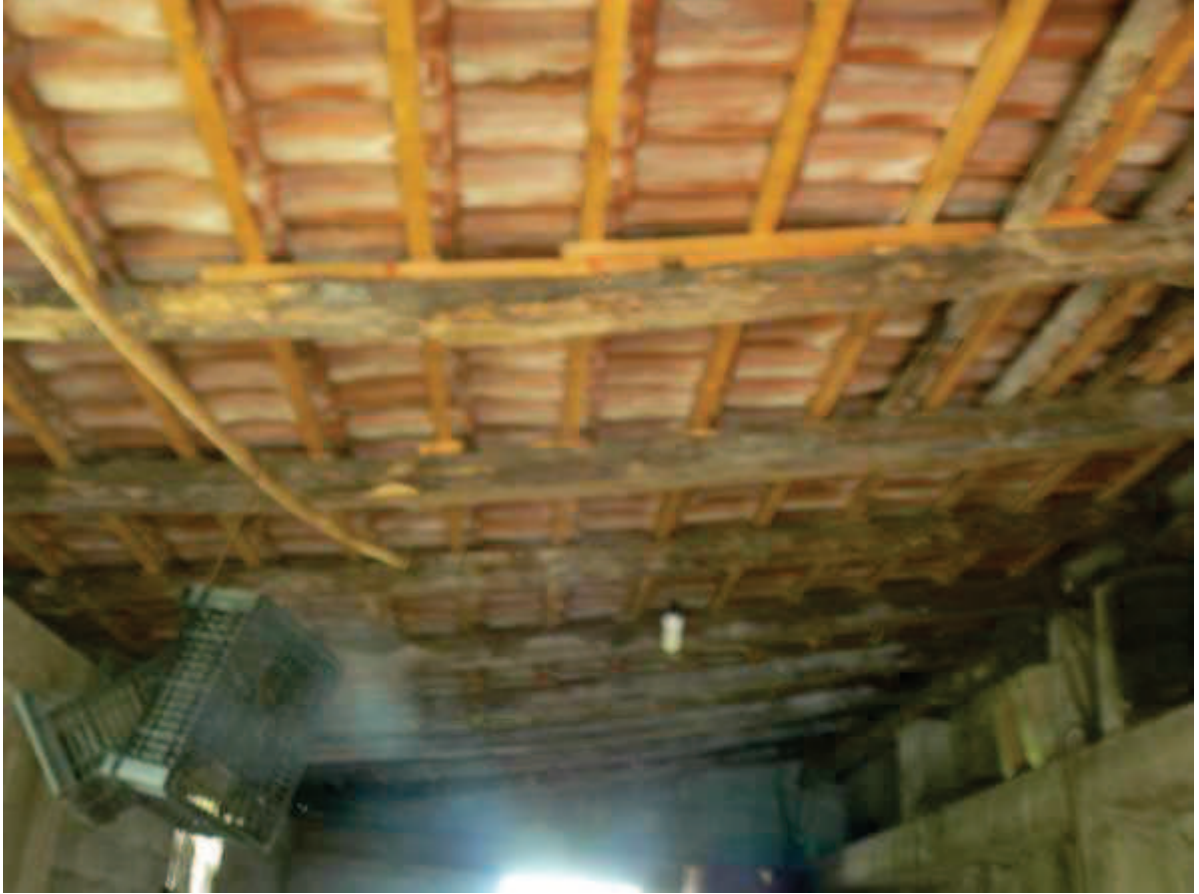
Figura 19 - Foglio 16 sub 4 part. 706 sub 4 - fienile, copertura
