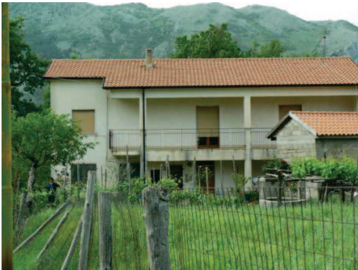
Figura 1 - Loc. Policeta - Foglio 16 part. 706 sub 3 (abitazione) e a destra sub 2 (deposito)
