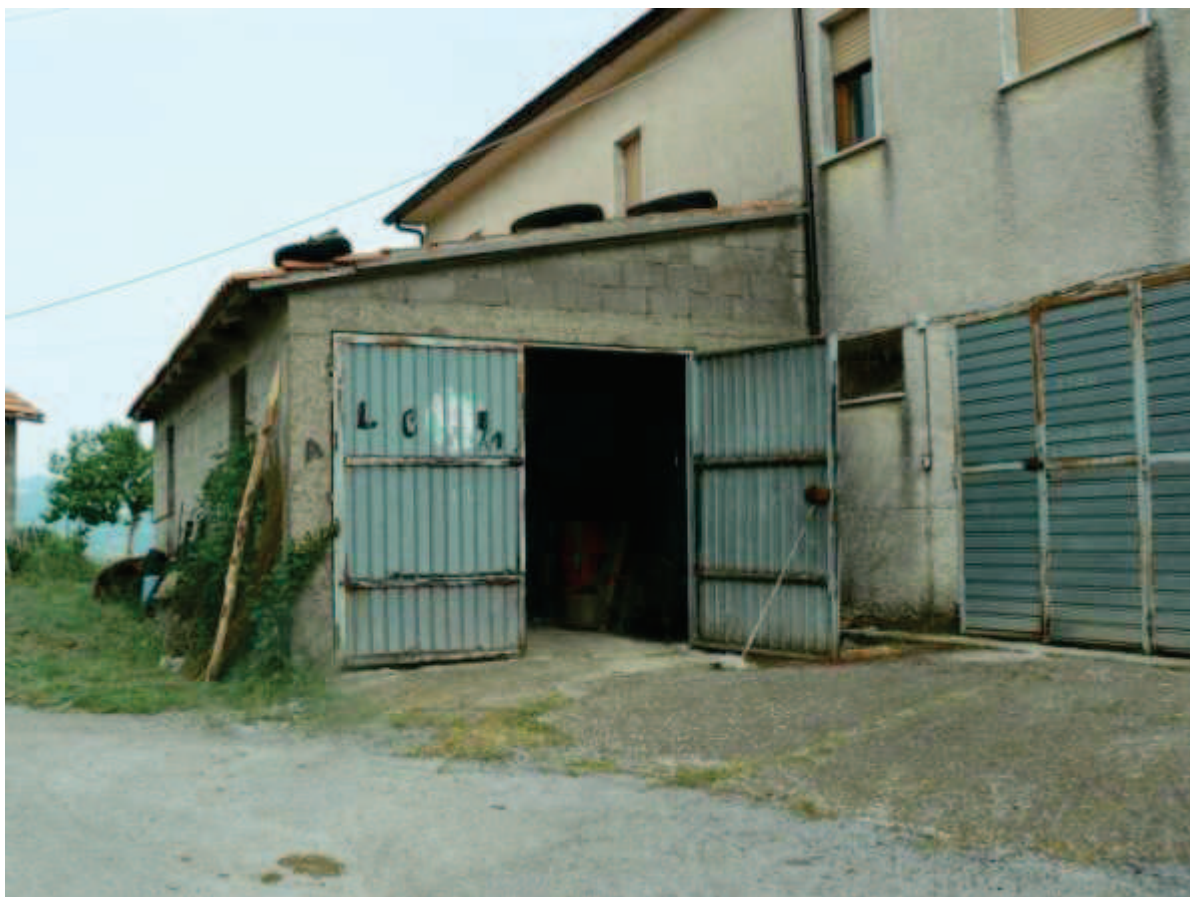
Figura 4 - Loc. Policeta - Foglio 16 part. 706 sub 3 (abitazione e cantina)
