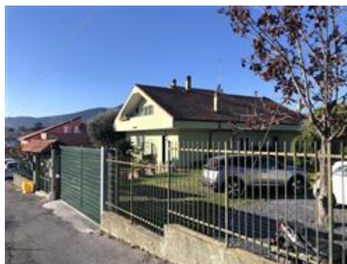
Casa di civile abitazione via Bulasce civ. 23A - viste generali esterne
