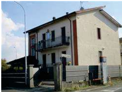
vista esterna della facciata principale lato nord
