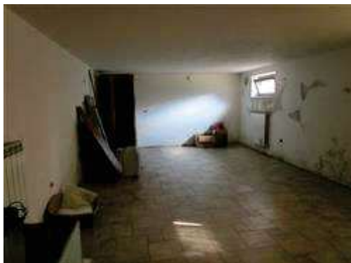
vista interna autorimessa
