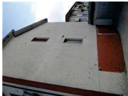
vista esterna con ingresso murato
