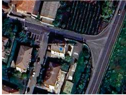
vista dell'immobile oggetto di perizia
