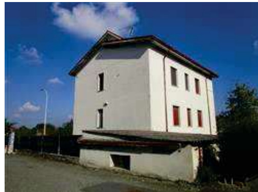
vista esterna del fabbricato lato sud ovest
