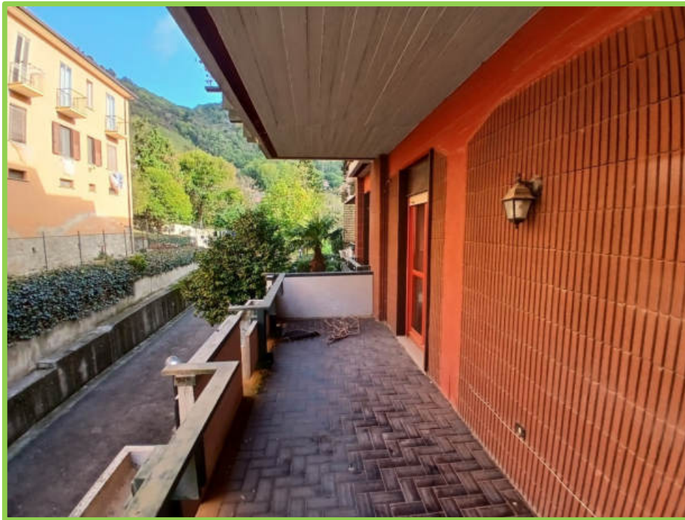
Immobilе oggetto di pignoramento - Balcone prospetto Nord-Ovest
