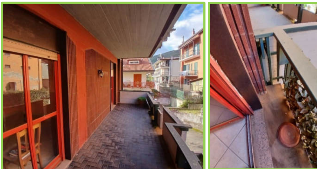
Immobile oggetto di pignoramento - Balconi prospetto Nord-Ovest
