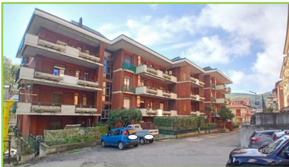
Fabbricato condominiale di cui fa parte l'immobile oggetto di pignoramento
